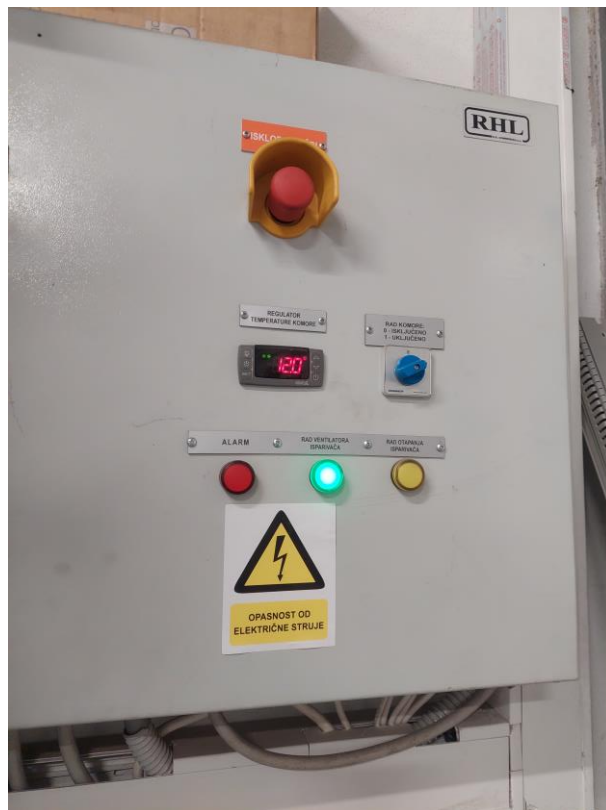
Slika 4.17. Sandučić za upravljanje hladnjačom
