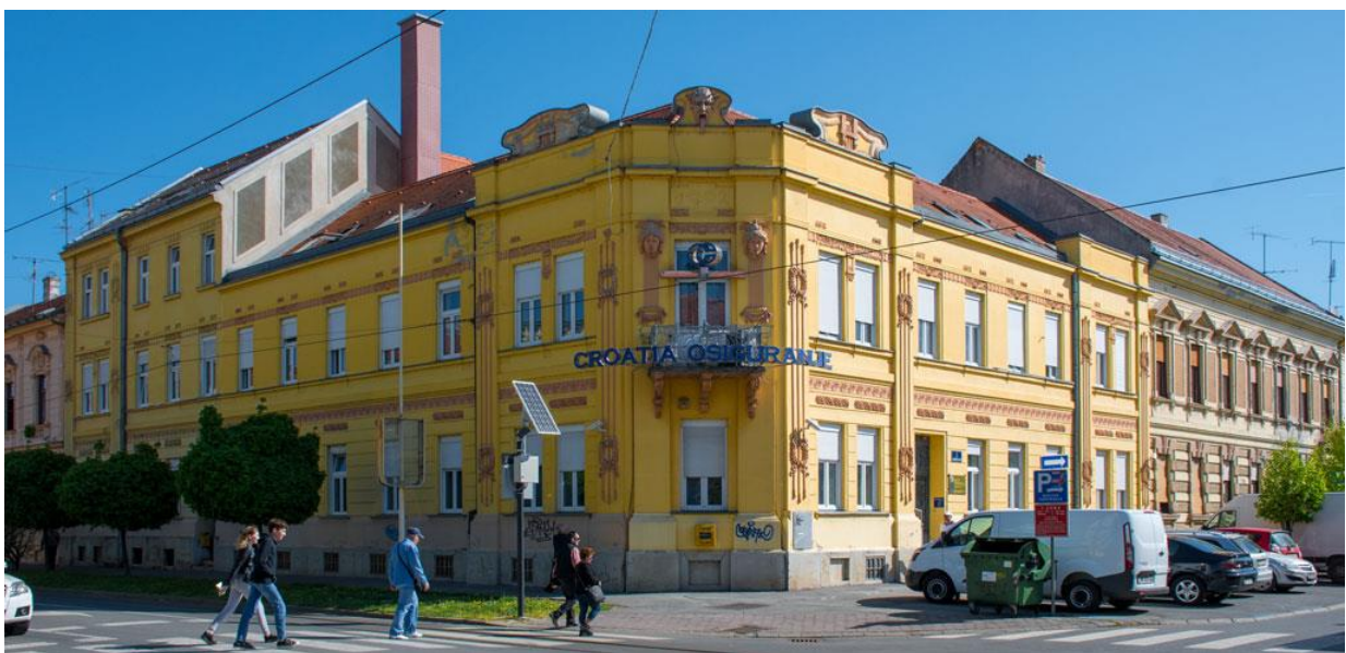
Slika 3-9 Kuća Bauer, Osijek
