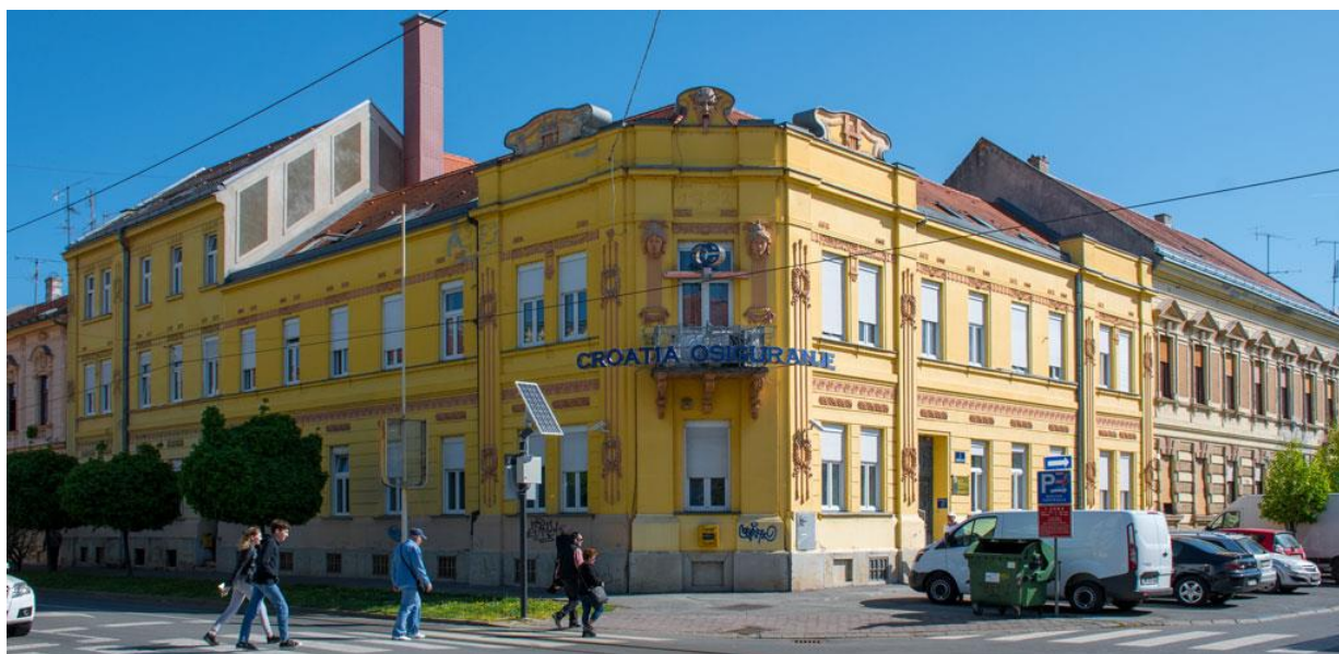
Slika 3-9 Kuća Bauer, Osijek
