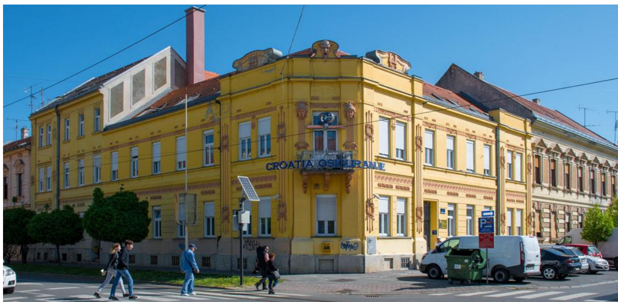
Slika 3-9 Kuća Bauer, Osijek
