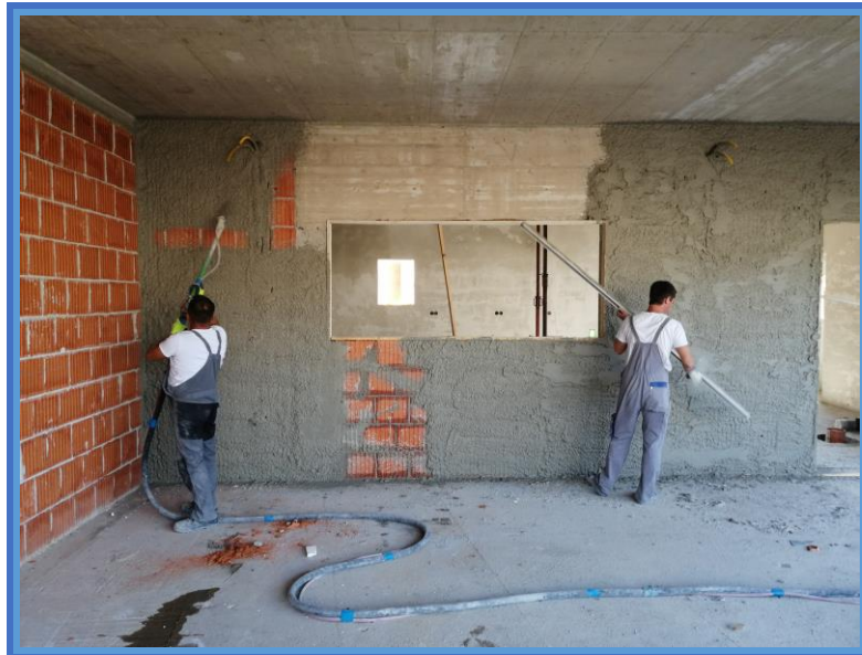
Slika 45. Strojno žbukanje zidova – zgrada 1 [8].
