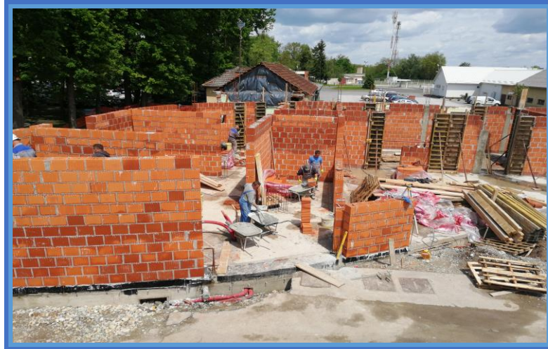
Slika 44. Zidanje nosivih zidova prizemlja – zgrada 1 [8].
