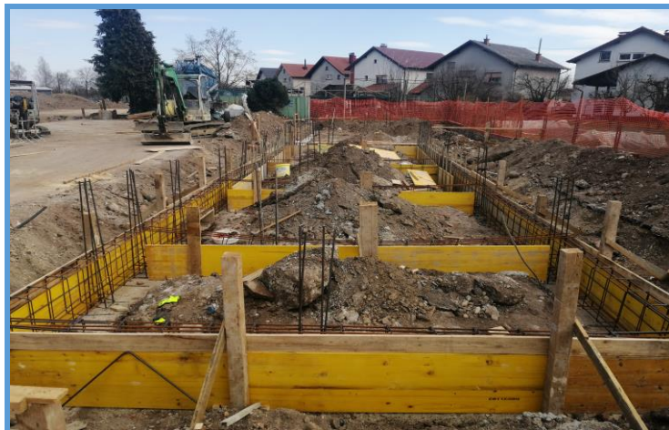
Slika 22. Betoniranje nadtemeljnih serklaža – zgrada 2 [8].
