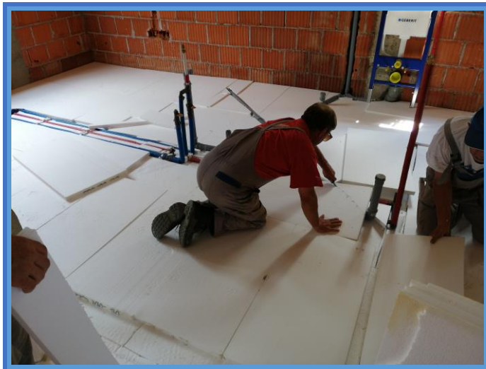
Slika 39. Polaganje EPS-a na podnu ploču [8].
