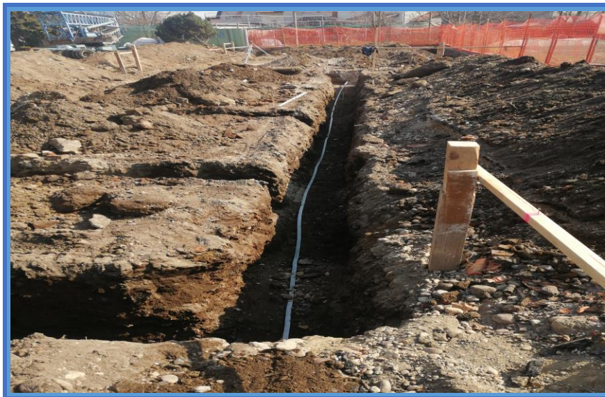
Slika 13. Iskop temeljnih traka-zgrada 2 [8].
