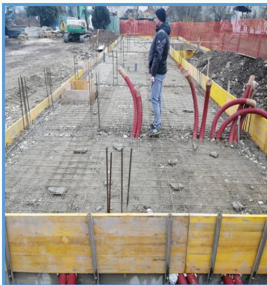
Slika 54. Cijevi za elektroinstalacije [8].
