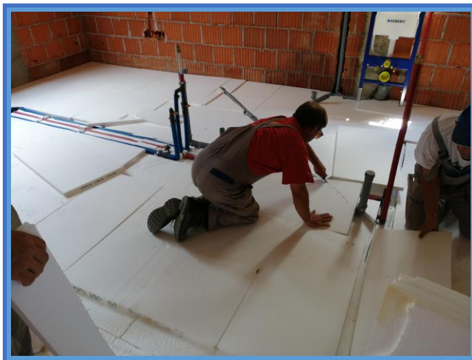
Slika 39. Polaganje EPS-a na podnu ploču [8].
