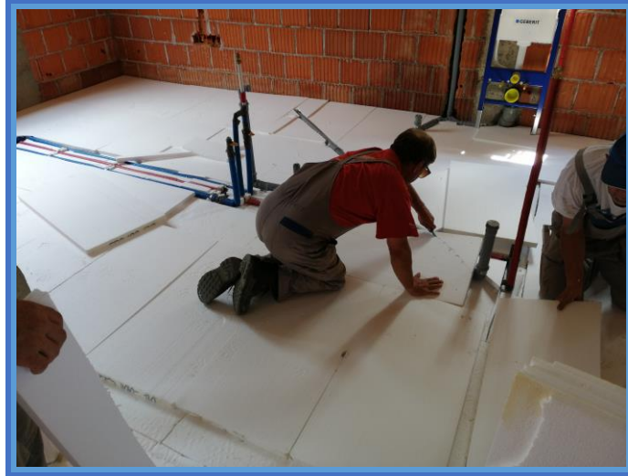
Slika 39. Polaganje EPS-a na podnu ploču [8].
