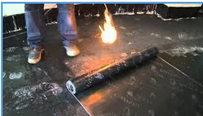
Slika 37. varenje ljepenke V4 [8].
