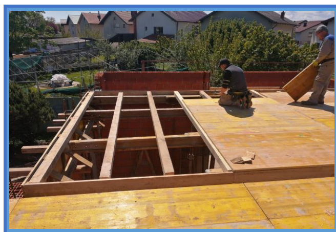
Slika 35. Šalovanje AB stropne ploče prizemlja [8].
