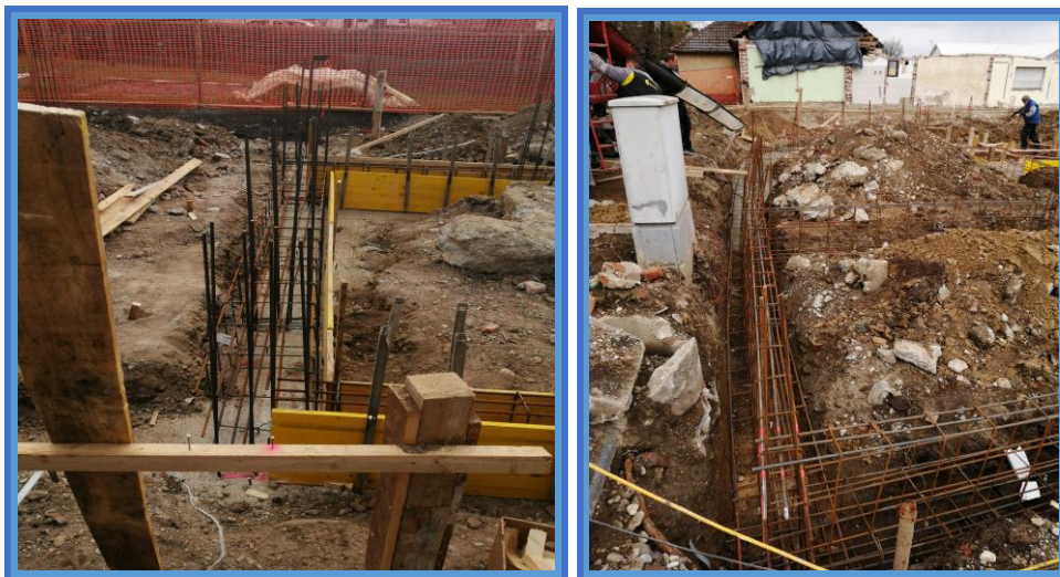
Slika 30. i 31. Armatura nadtemeljnih serklaža [8].
