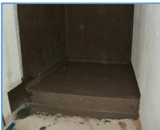
Slika 38. dvokomponentna polimercementna hidroizolacija [8].
