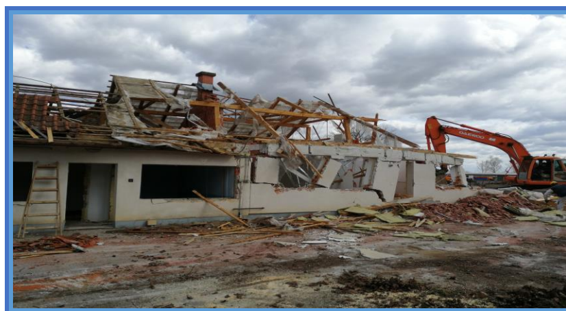
Slika 7. Rušenje postojećih zgrada na parceli [8].
