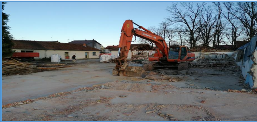
Slika 9. Rušenje postojećih zgrada na parceli [8].
