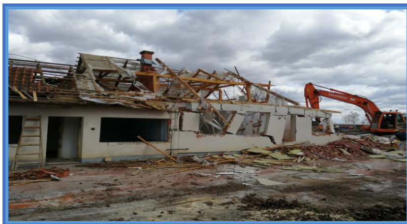
Slika 7. Rušenje postojećih zgrada na parceli [8].
