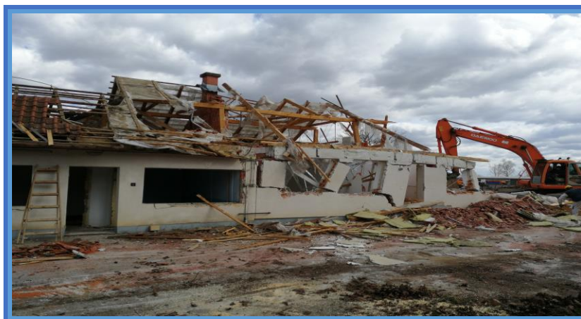
Slika 7. Rušenje postojećih zgrada na parceli [8].
