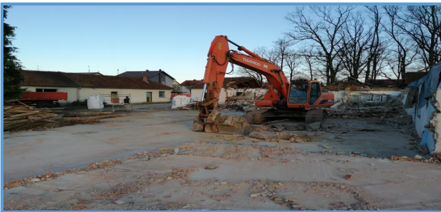
Slika 9. Rušenje postojećih zgrada na parceli [8].
