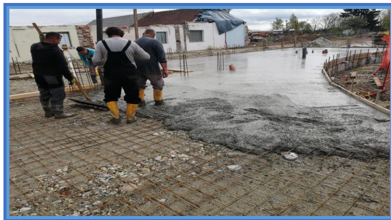
Slika 25. Betoniranje podne ploče prizemlja – zgrada 1 [8]
