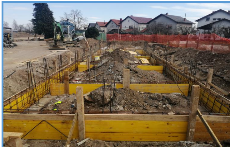
Slika 22. Betoniranje nadtemeljnih serklaža – zgrada 2 [8].
