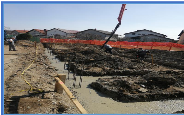
Slika 20. Betoniranje temeljnih traka – zgrada 2 [8].
