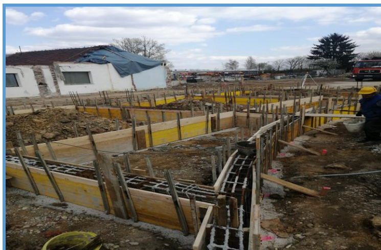
Slika 23. Betoniranje nadtemeljnih serklaža – zgrada 1 [8].
