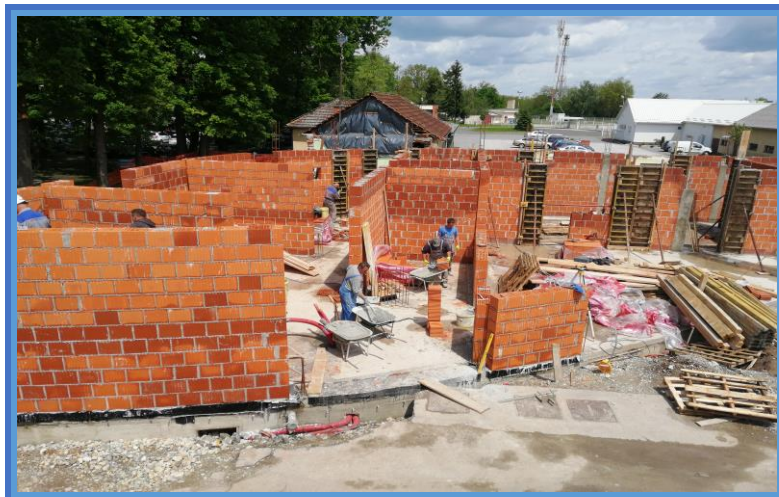
Slika 44. Zidanje nosivih zidova prizemlja – zgrada 1 [8].
