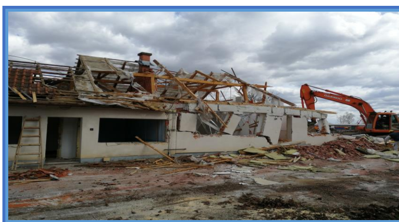
Slika 7. Rušenje postojećih zgrada na parceli [8].
