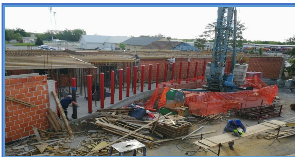
Slika 47. Postavljanje čeličnih stupova nosača fiksne ostakljene stijene [8].
