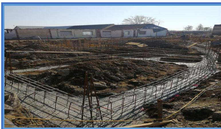
Slika 21. Betoniranje temeljnih traka – zgrada 1 [8].
