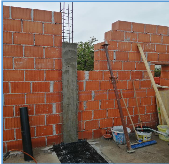
Slika 26. AB vertikalni serklaž [8].
