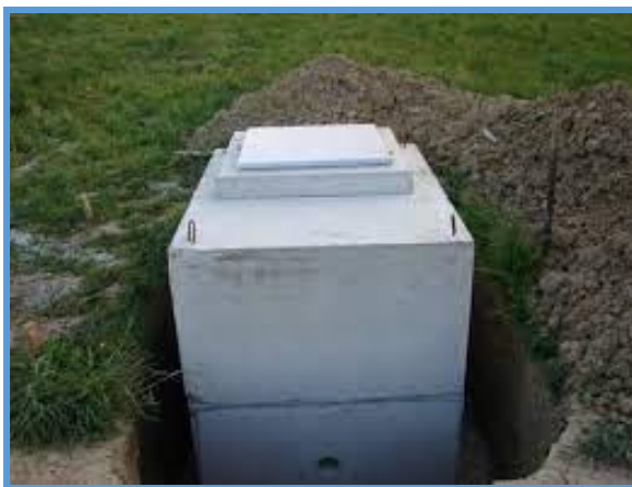
Slika 49. AB vodomjerno okno [8].
