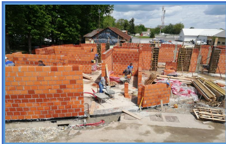
Slika 44. Zidanje nosivih zidova prizemlja – zgrada 1 [8].
