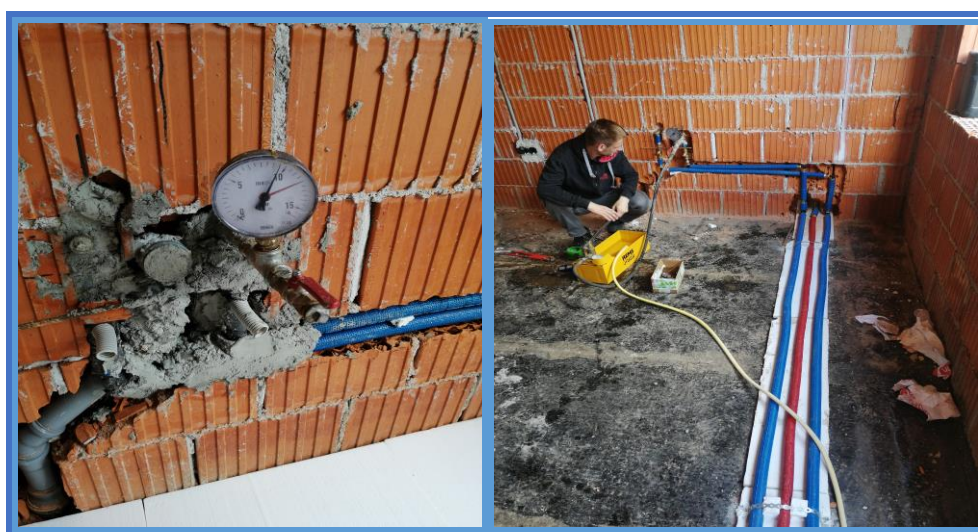
Slika 50. Tlačna proba cjevovoda [8].
