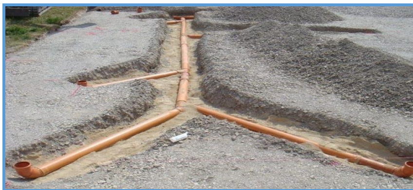
Slika 52. Postava kanalizacijskih cijevi [8].
