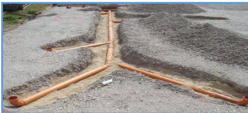
Slika 52. Postava kanalizacijskih cijevi [8].
