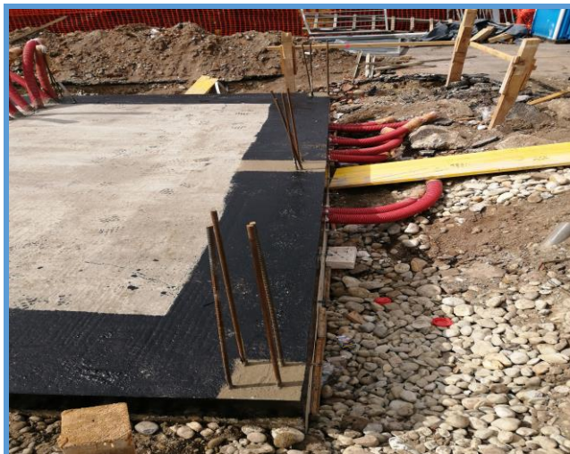
Slika 36. Premaz resitolom [8].
