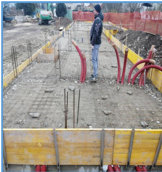
Slika 54. Cijevi za elektroinstalacije [8].
