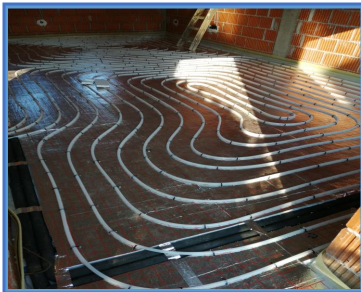
Slika 56. Postava cijevi za podno grijanje [8].
