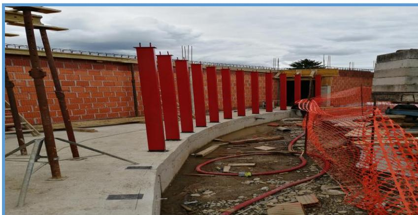
Slika 46. Postavljanje čeličnih stupova nosača fiksne ostakljene stijene [8].
