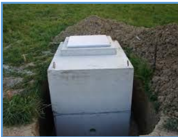
Slika 49. AB vodomjerno okno [8].
