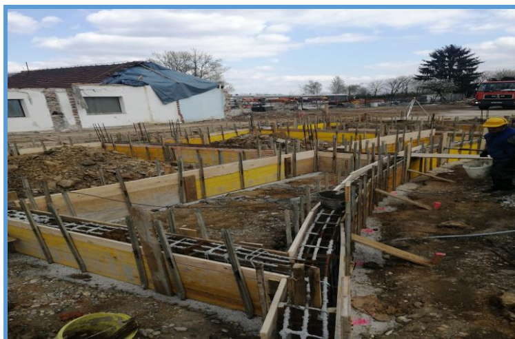
Slika 23. Betoniranje nadtemeljnih serklaža – zgrada 1 [8].
