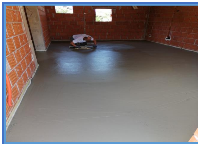
Slika 29. Izrada glazure [8].
