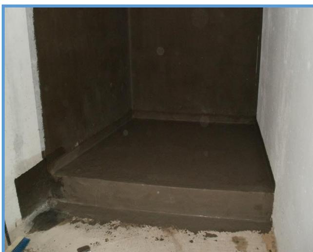
Slika 38. dvokomponentna polimercementna hidroizolacija [8].
