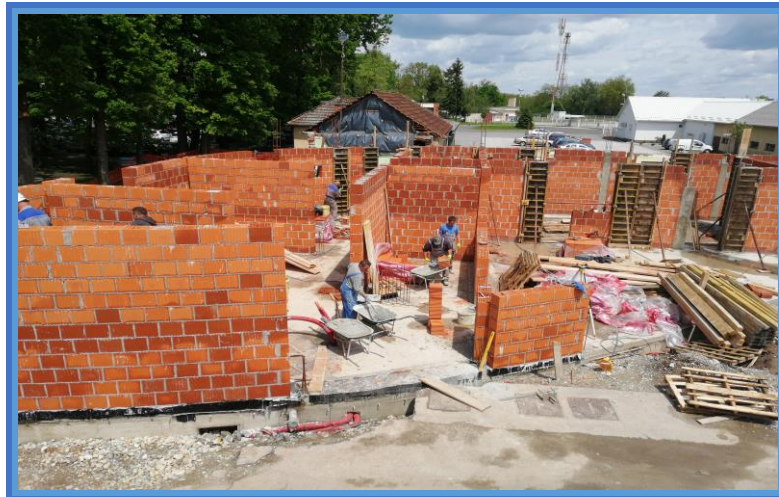
Slika 44. Zidanje nosivih zidova prizemlja – zgrada 1 [8].
