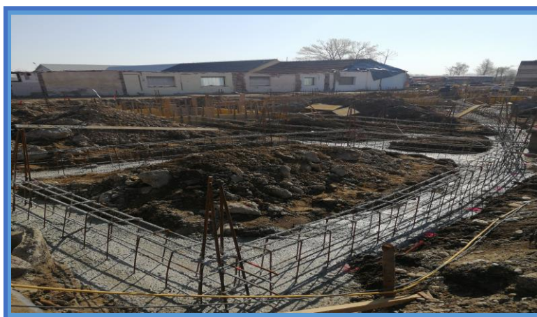
Slika 21. Betoniranje temeljnih traka – zgrada 1 [8].
