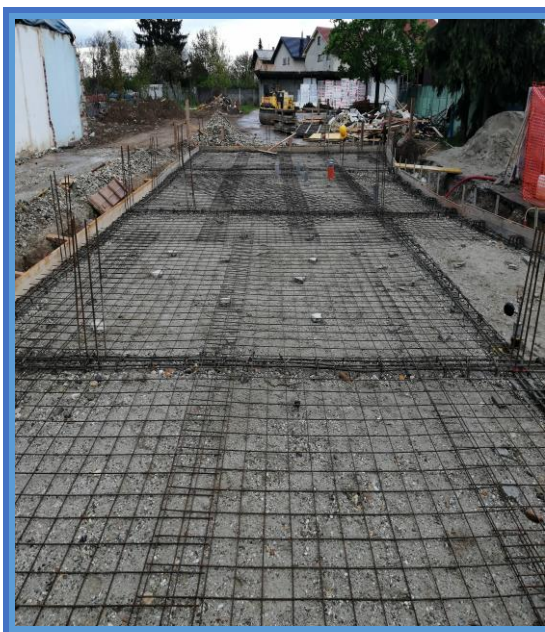
Slika 32. armatura ploče [8].
