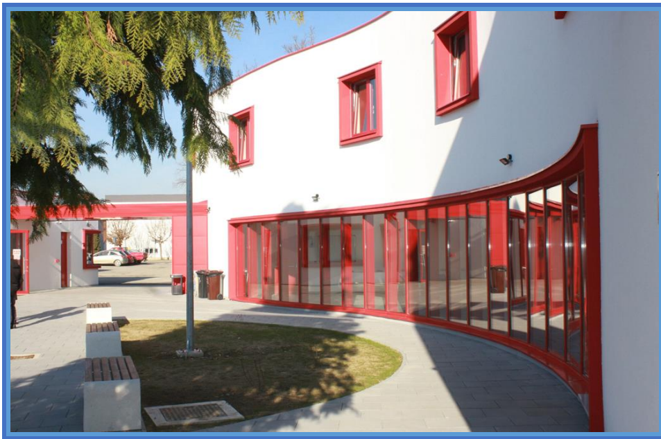
Slika 48. Fiksna ostakljena zakrivljena stijena – zgrada 1 [8].
