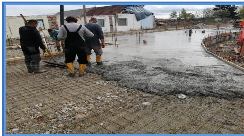
Slika 25. Betoniranje podne ploče prizemlja – zgrada 1 [8]
