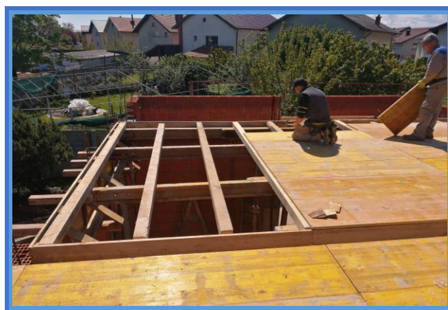
Slika 35. Šalovanje AB stropne ploče prizemlja [8].
