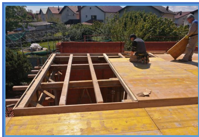
Slika 35. Šalovanje AB stropne ploče prizemlja [8].
