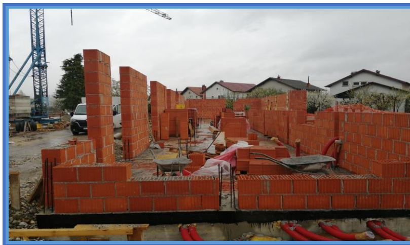
Slika 43. Zidanje nosivih zidova prizemlja – zgrada 2 [8].
