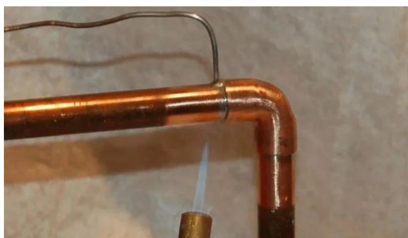
*Slika 6.4. Tvrdo lemljenje koljenastog spoja*
