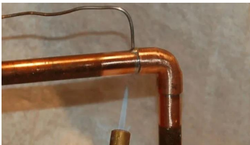
Slika 6.4. Tvrdo lemljenje koljenastog spoja
