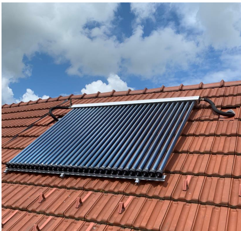
Slika 6.7.4. Razdjelnik spojen sa kolektorima i gibljivim cijevima, (Ivan Podravec-24.4.2023.)
