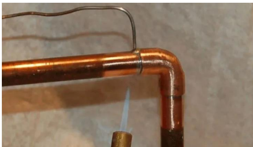
Slika 6.4. Tvrdo lemljenje koljenastog spoja
