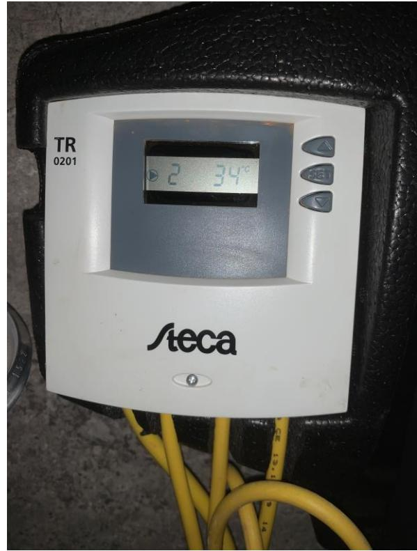
Slika 6.9. Solarni regulator spojen sa električnim naponom i osjetnicima, (Ivan Podravec-2.5.2023.)
