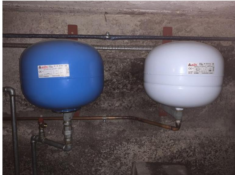
Slika 6.5.2. Ekspanzijske posude spojene na solarni sustav i PTV,(Ivan Podravec-17.4.2023.)
