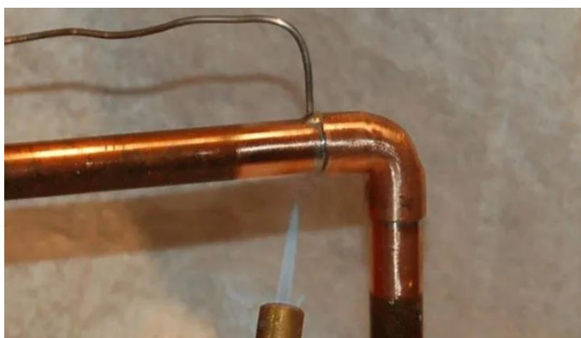
Slika 6.4. Tvrdo lemljenje koljenastog spoja
