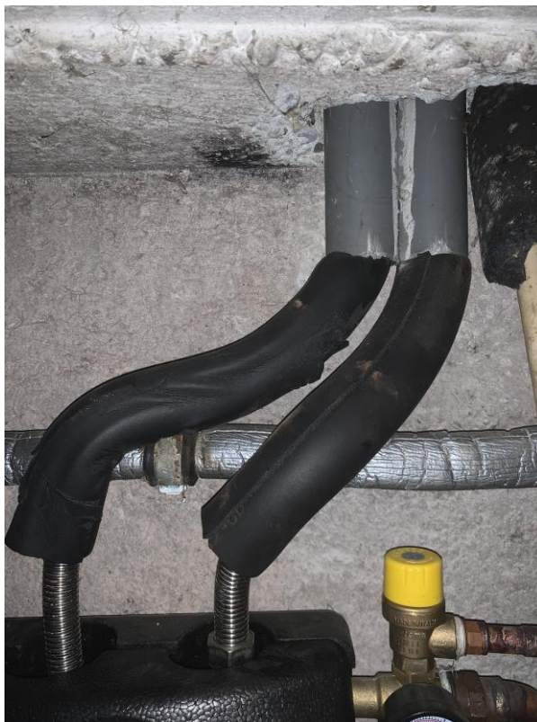
Slika 6.5.1. Prikaz spoja gibljivih cijevi sa solarnom stanicom, (Ivan Podravec-11.4.2023.)
