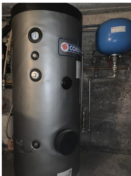
Slika 6.1. Spremnik tople vode od 300 litara, (Ivan Podravec- 2.3.2023.)
