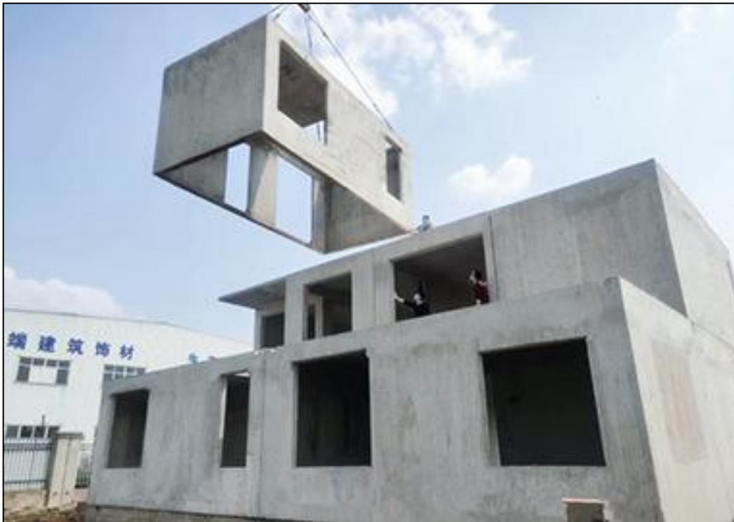
Slika 18: Montaža modularnog betonskog objekta (izvor: https://www.tengcang66.com/ )
