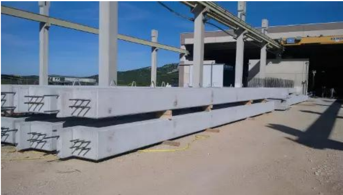
Slika 36: Tijek izrade i doprema predgotovljenog betonskog stupa na gradilište (izvor: osobna arhiva)
