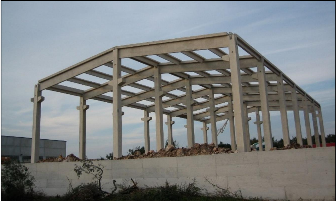
Slika 16: Montažna betonska nosiva konstrukcija industrijske hale (izvor: http://betoncommerce.hr/portfolio-view/montazne-hale/ )
