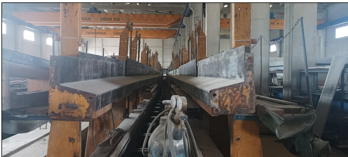
Slika 25: Unutašnjost pogona Beton Lučko d.o.o. (izvor: osobna arhiva)
