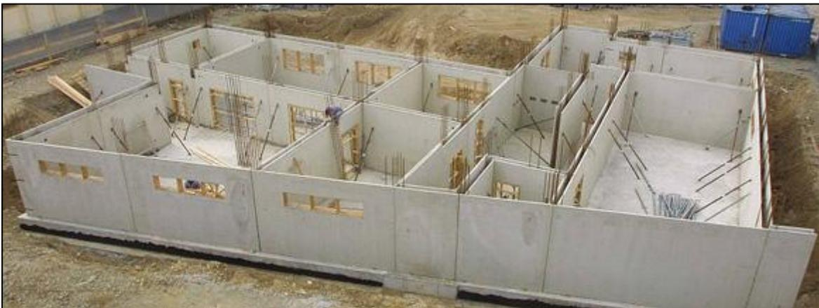
Slika 11: Primjer velikoplošnog sustava – polumontažni sistem „Beton Lučko“ (izvor: <https://www.betonlucko.hr/polumontazni-sistemi-gradjenja.html>, pregledano 20.10.2022.)
