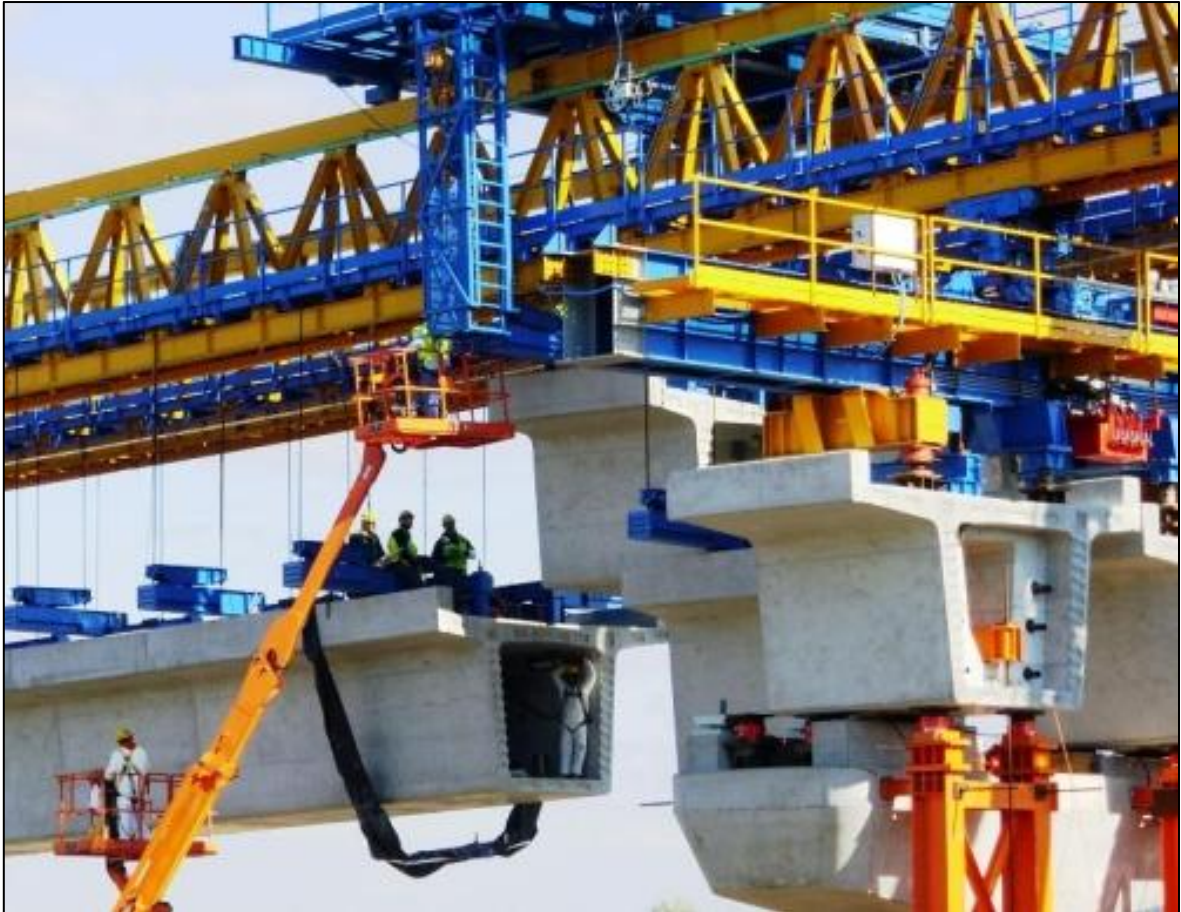
Slika 4: Ugradnja prefabriciranog sandučastog nosača mosta na lokaciju ugradnje (izvor: https://www.gradjevinarstvo.rs/tekstovi/5445/820/betonski-segmentni-mostovi , pregledano 20.10.2022.)
