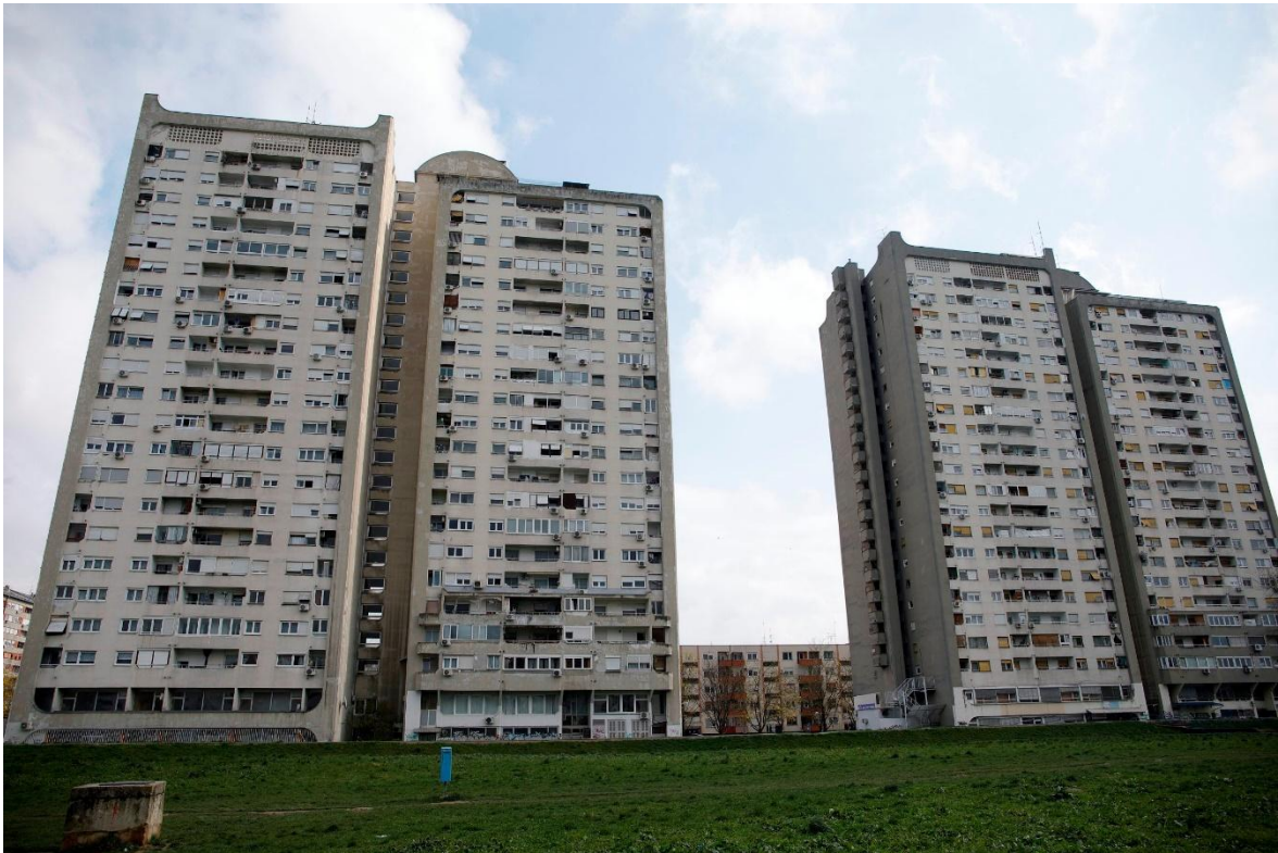
Slika 13: Sistem Larsen-Nielsen na primjeru novozagrebačkih nebodera (izvor: https://www.jutarnji.hr/domidizajn/interijeri/otporni-na-potres-zagrebacke-visekatnice-i-neboderi-tresu-se-i-plesu-ali-u-nedjelju-su-gotovo-neosteceni-10146751 )
