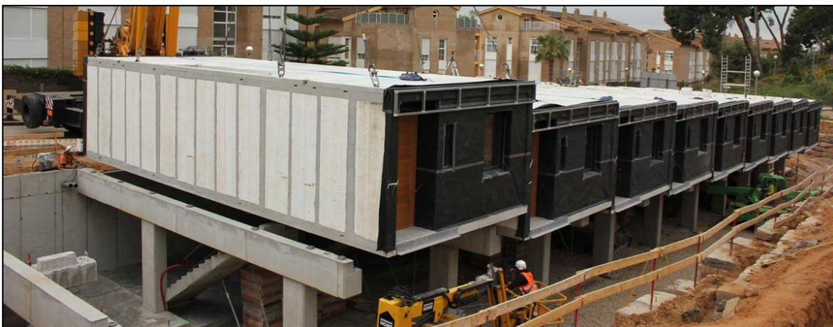
Slika 19: Primjer mješovitog sustava (izvor: https://www.compacthabit.com/advantages/ )
