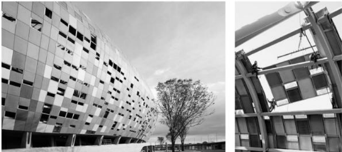
Slika 37: Soccer City stadion u Johhanesburgu izgrađen 1987. sastoji se od 2400 modula izrađenih od prefabriciranog betona ojačanog staklenim vlaknima (izvor: https://books.google.hr/books?id=xbq_zqFZqQQC&printsec=frontcover&hl=hr&source=gbs_atb#v=onepage&q&f=false )
