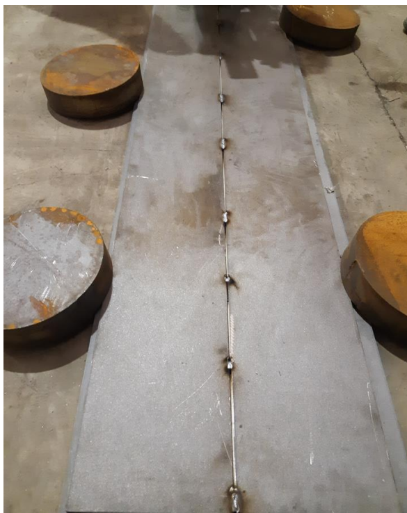
Slika 5.4.: Pripajanje ploča prije zavarivanja [34]
