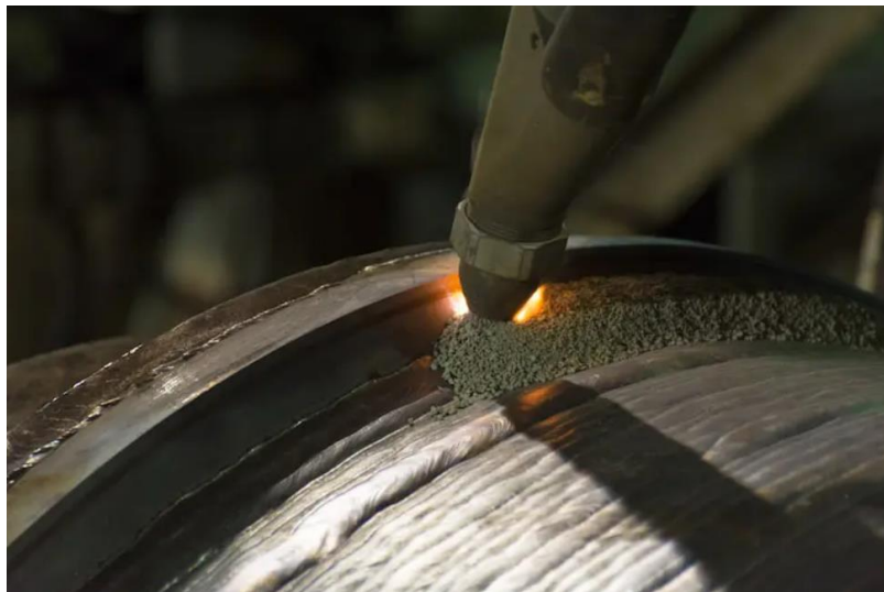
Slika 2.3.: Elektrolučno zavarivanje pod zaštitom praška [6]
