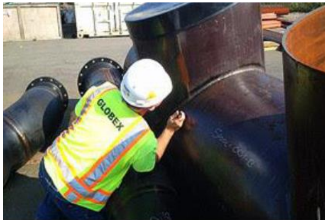
Slika 3.1.: Provođenje vizualnog ispitivanja zavarenog spoja [12]
