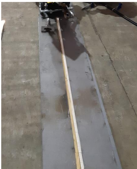
Slika 5.3.: Postavljanje ploča prije zavarivanja [34]
