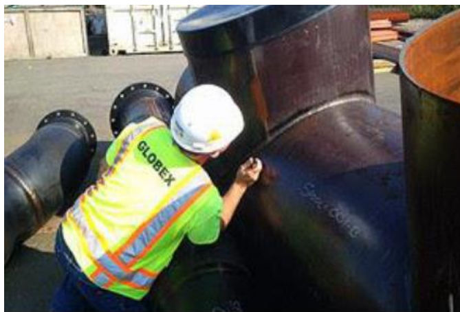
Slika 3.1.: Provođenje vizualnog ispitivanja zavarenog spoja [12]
