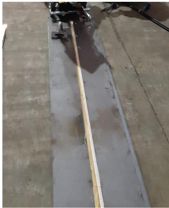
*Slika 5.3.: Postavljanje ploča prije zavarivanja [34]*
