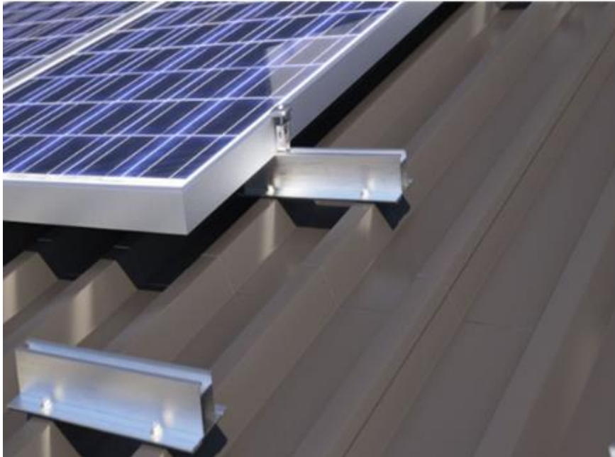
Slika 5. Konstrukcijski elementi za postavljanje panela na lim [13].
