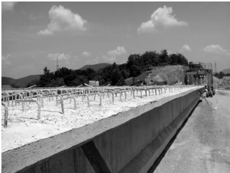
Sl.2.2.1. Proizvodnja predgotovljenih elemenata na gradilištu [12]
