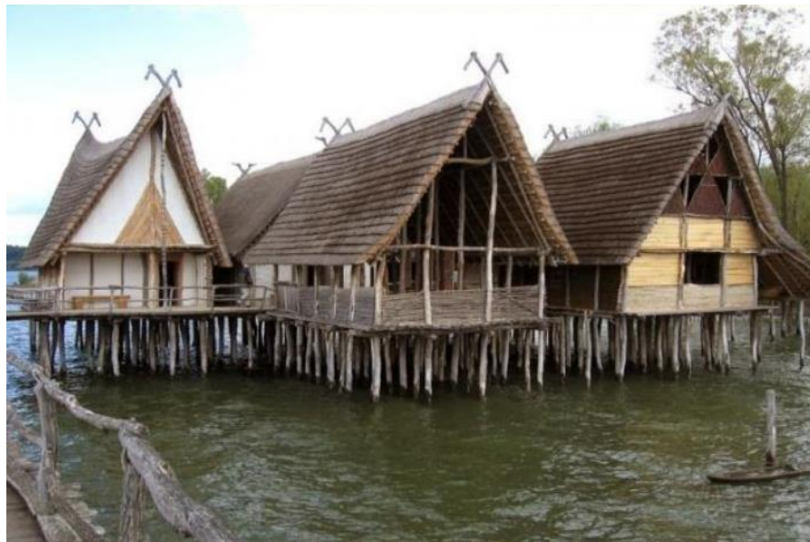
Sl 4.3.5. Drveni piloti [10]
