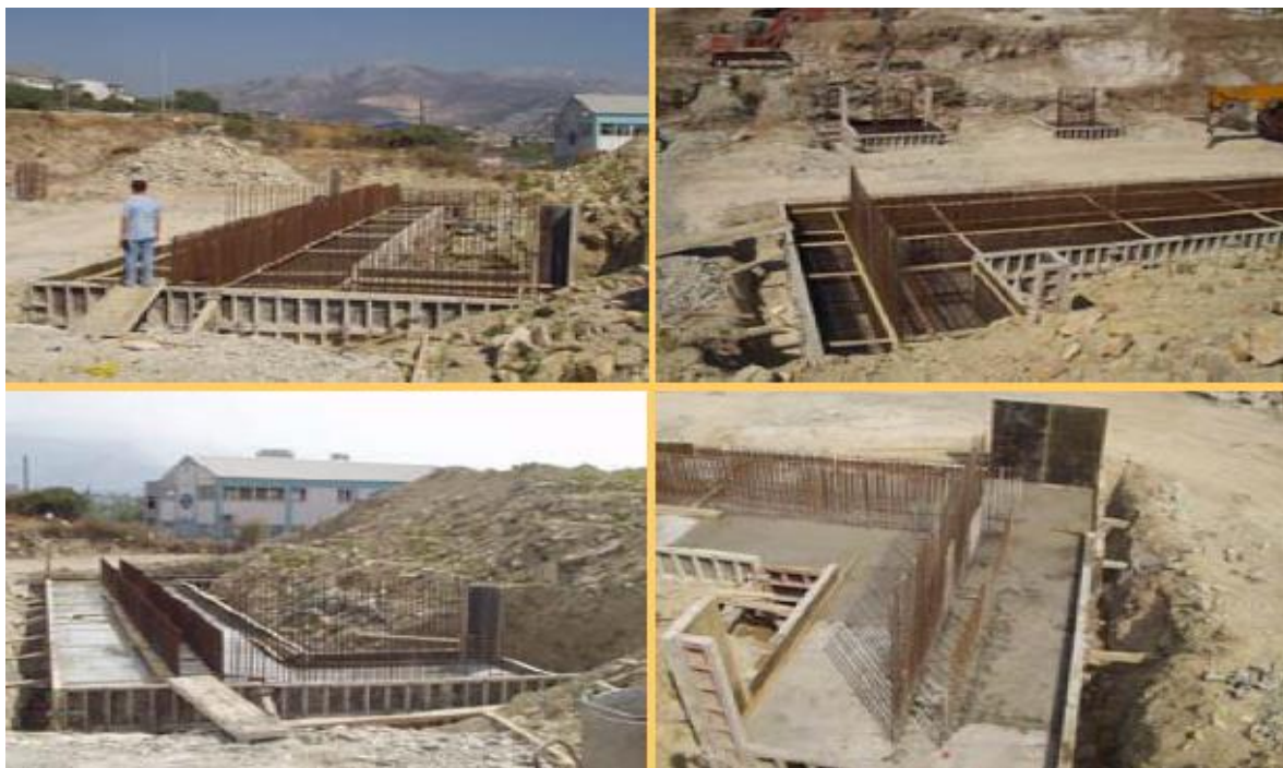
Sl.6.2.3. Izvedba temelja upornjaka za nadvožnjak Mercatone, Kaštel Sućurac [11]
