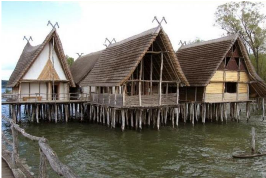
Sl 4.3.5. Drveni piloti [10]
