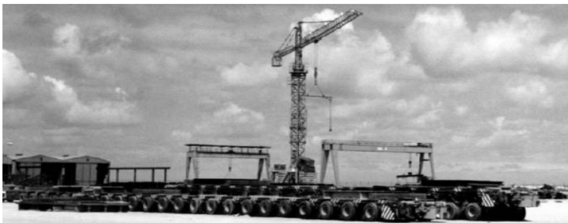
Sl.2.2.2. Dizalica za utovar i vozila za transport elementa [12]
