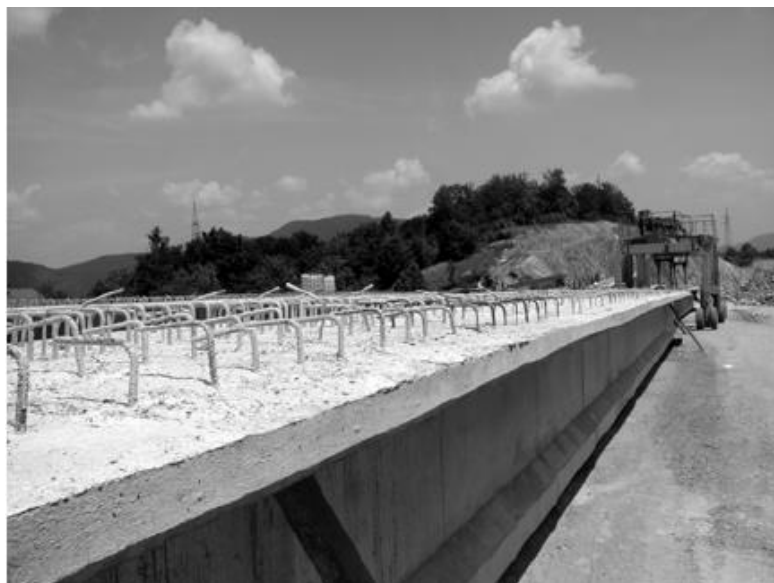
Sl.2.2.1. Proizvodnja predgotovljenih elemenata na gradilištu [12]
