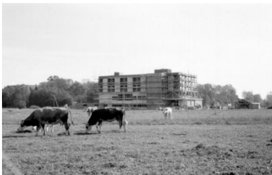
Fotografija 1. Početak izgradnje Hotela „Park“ u Čakovcu
