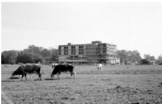
Fotografija 1. Početak izgradnje Hotela „Park“ u Čakovcu
