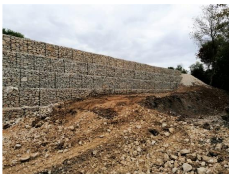
Slika.14. Gabionski zid
