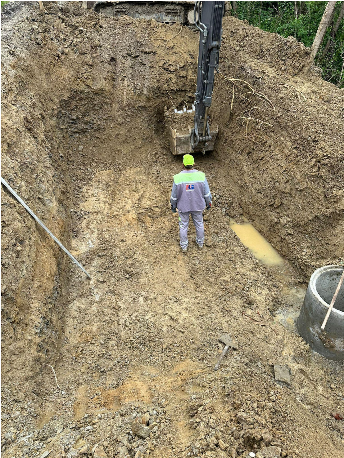
Slika.24. iskop materijala
