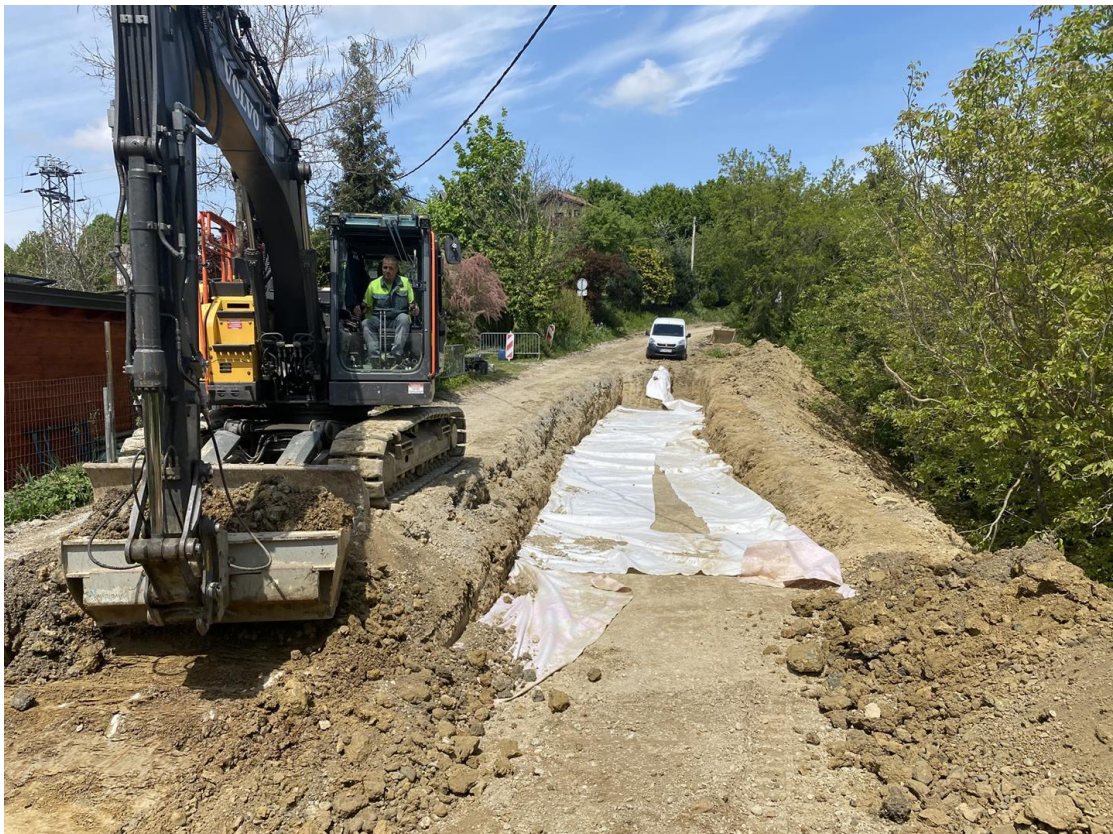
Slika.28. Ugradnja nosivog materijala u kolničku konstrukciju 2
