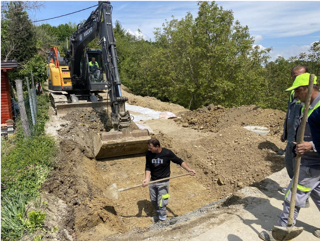
Slika.27. Ugradnja nosivog materijala u kolničku konstrukciju 1
