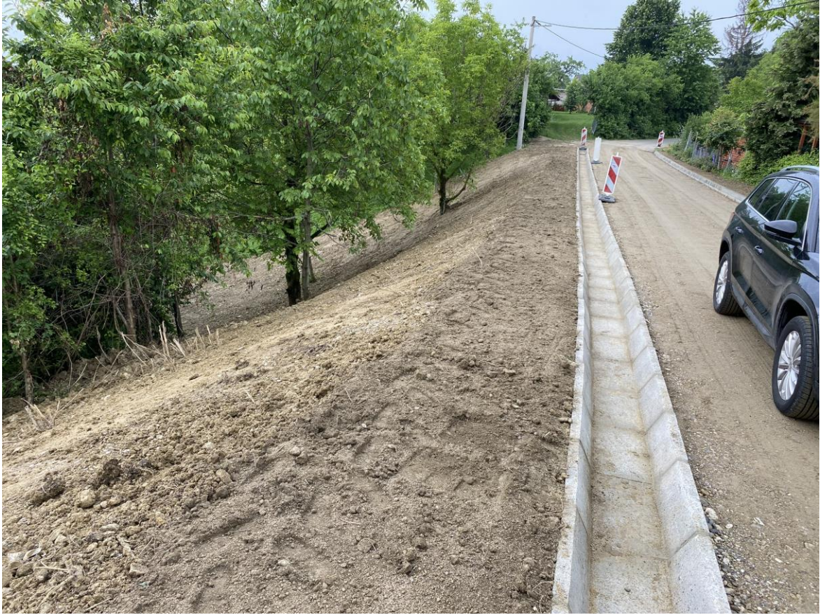
Slika.30. Uređeni pokos klizišta
