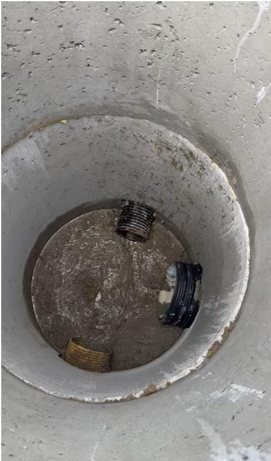
Slika.26. Unutrašnjost reviziskog okna
