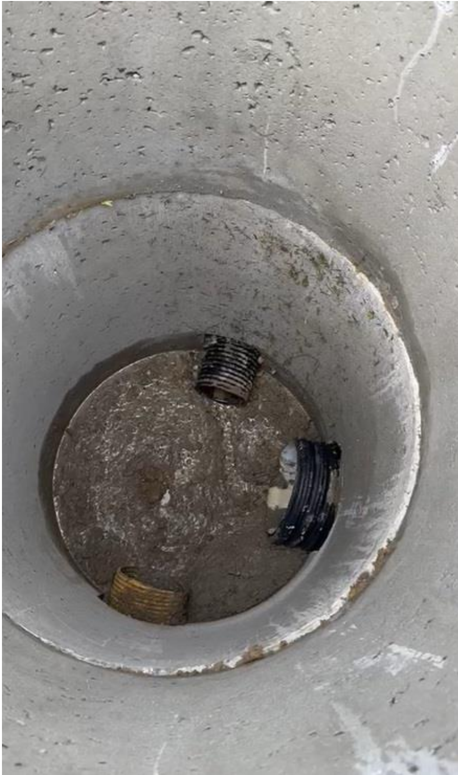
Slika.26. Unutrašnjost reviziskog okna
