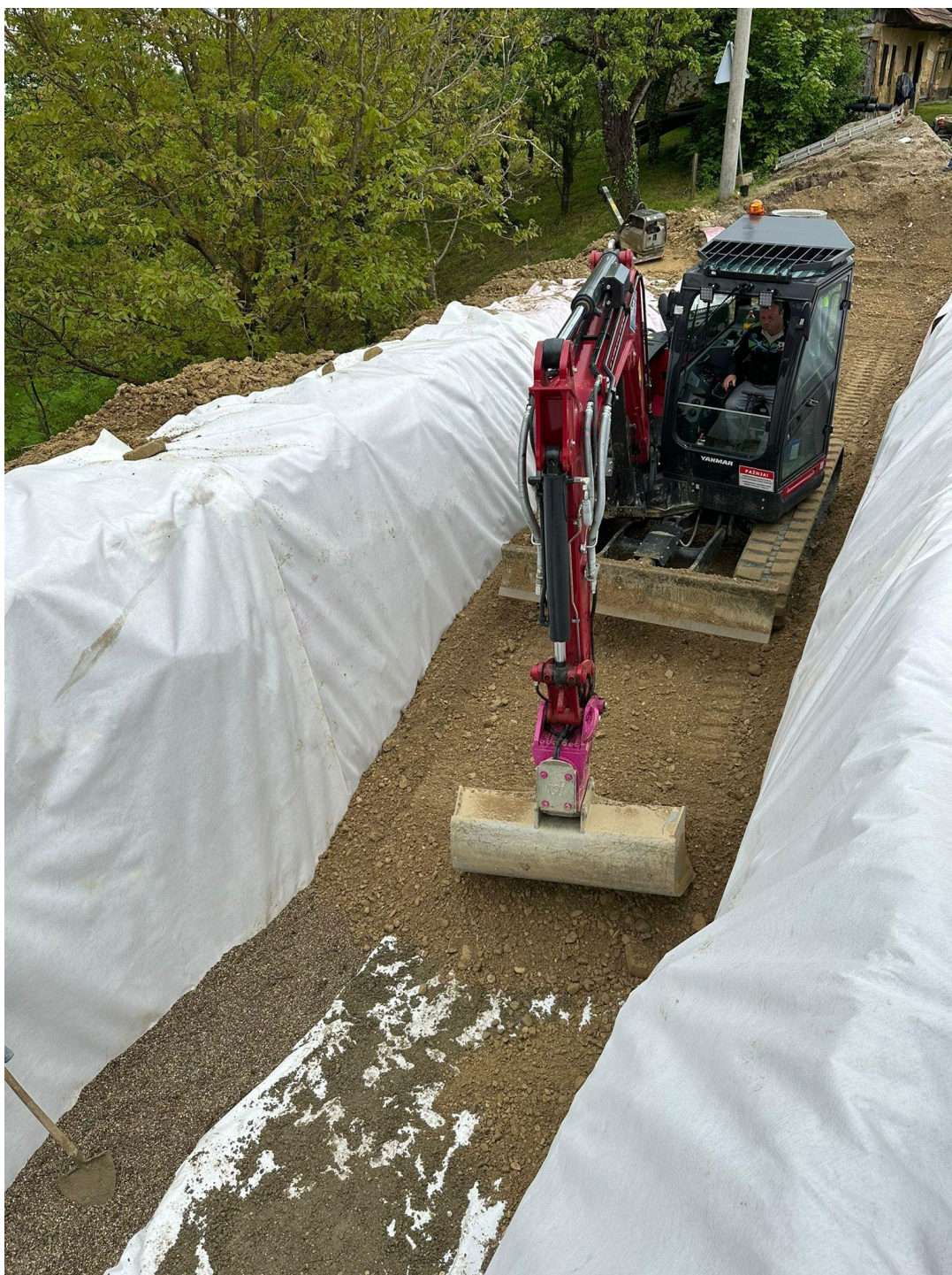
Slika.25. zamjena iskopanog materijala šljunčanim materijalom na pripremljenu podlogu obloženom geotekstilom
