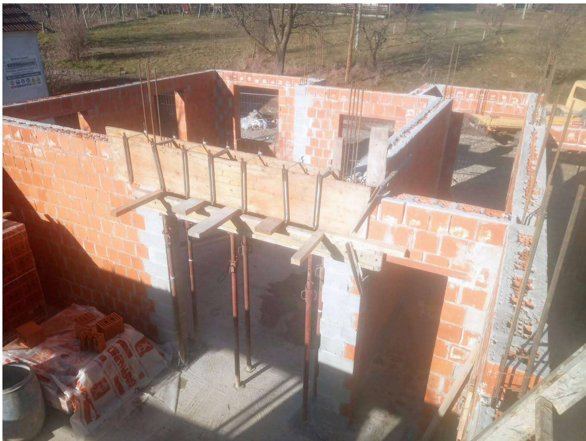
Slika 3.5.1. Prikaz montirane oplata
