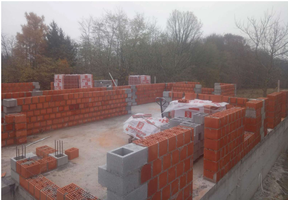
Slika 3.4.1. Zidanje nosivih zidova
