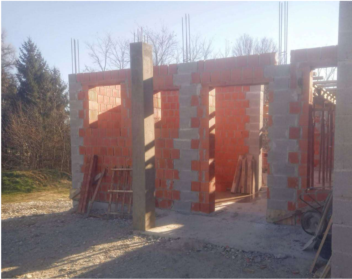
Slika 3.2.2. Betoniranje stupa
