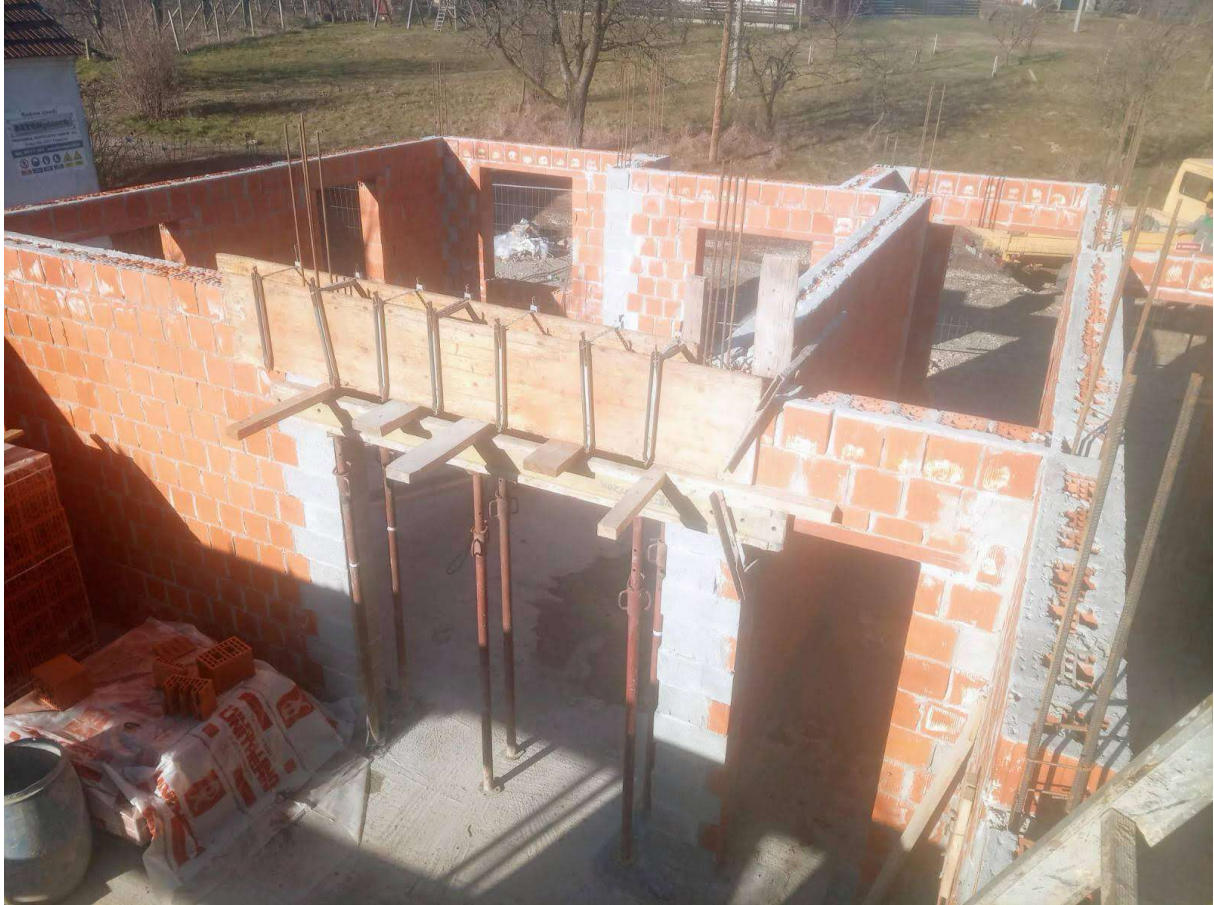
Slika 3.5.1. Prikaz montirane oplata
