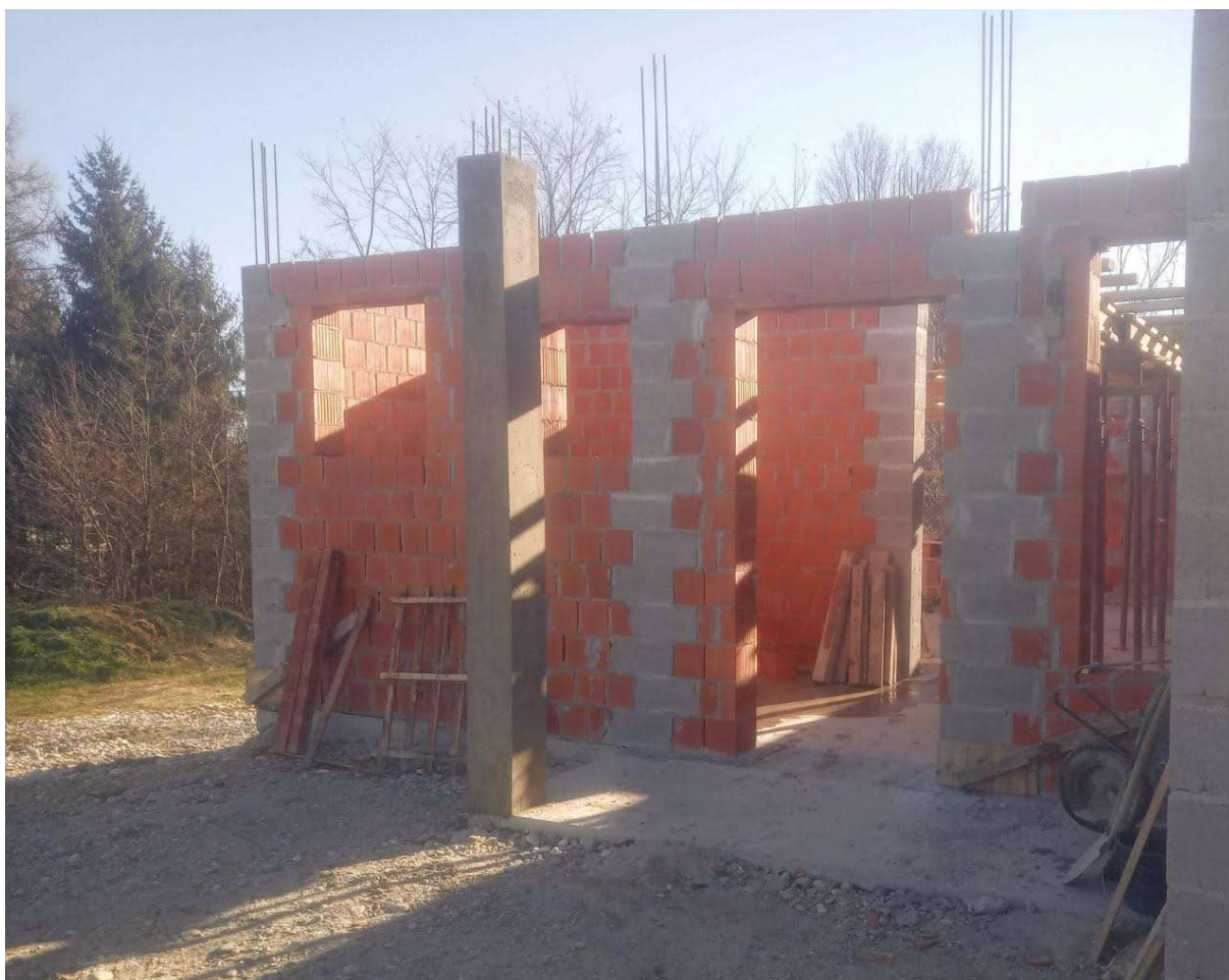
Slika 3.2.2. Betoniranje stupa
