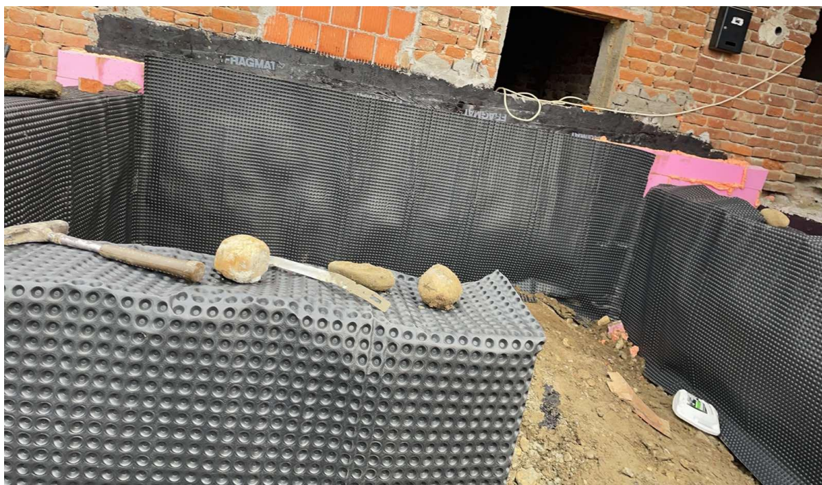
Slika 4.1 – Priprema za dogradnju ulaznog dijela građevina
