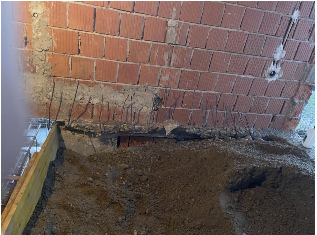
Slika 4.14 – Ispuna „slijepog podruma“ – drugi dio
