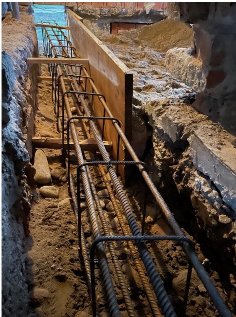
Slika 4.6 – Priprema temelja za povezivanje s dograđenim dijelom
