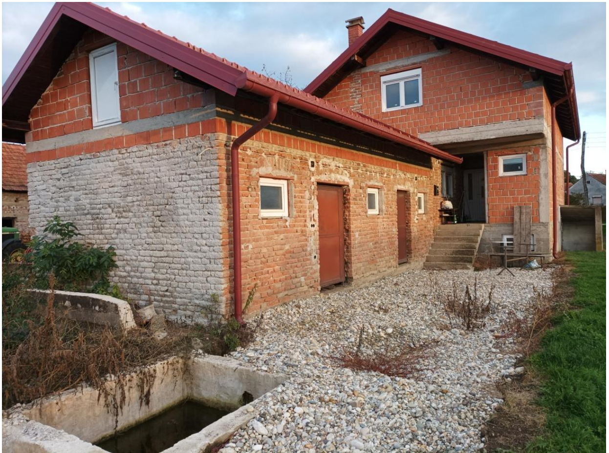
Slika 3.1 – Vanjski izgled građevine
