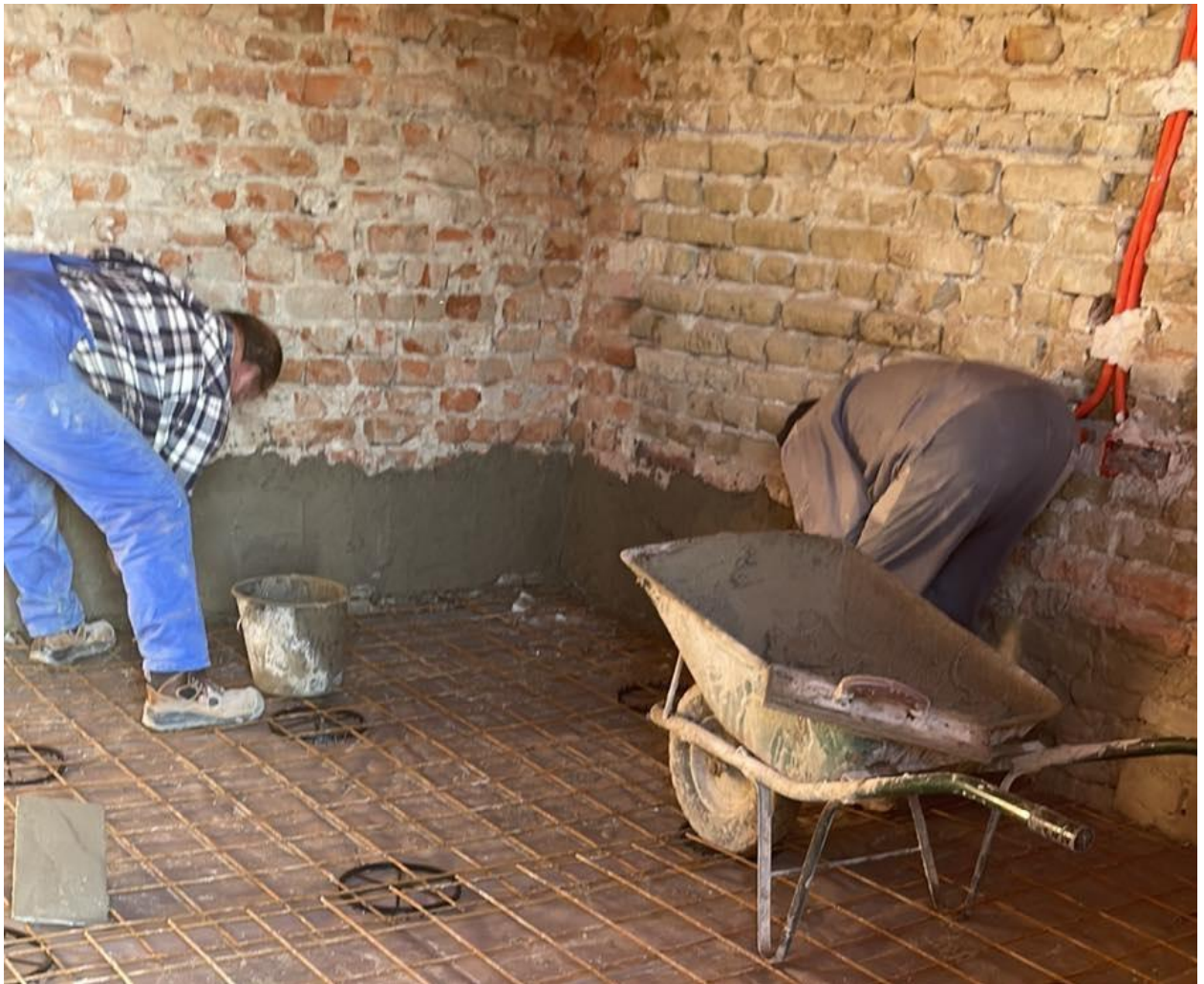
Slika 4.16 – Ručno nanošenje hidroizolacije
