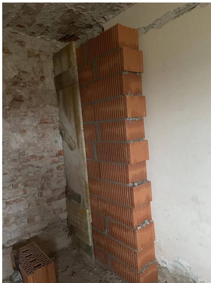
Slika 4.9 – Izrada novog nosivog zida
