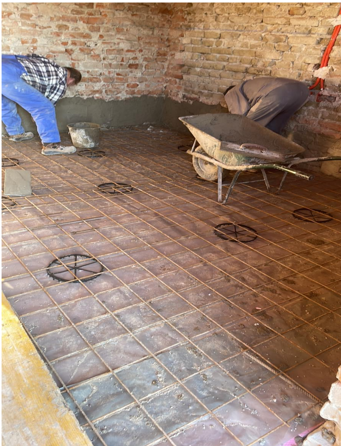
Slika 4.17 – Priprema za izrada temeljne ploče
