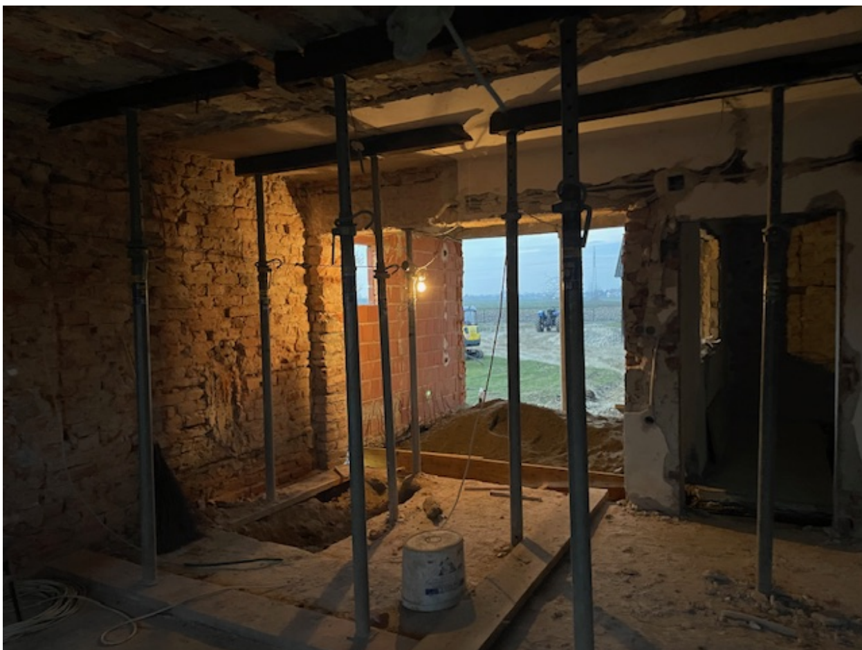
Slika 4.7 – Podupiranje postojeće konstrukcije
