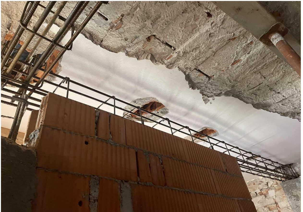
Slika 4.10 – Greda novog nosivog zida
