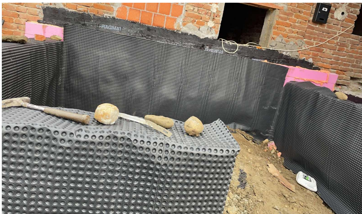
Slika 4.1 – Priprema za dogradnju ulaznog dijela građevina
