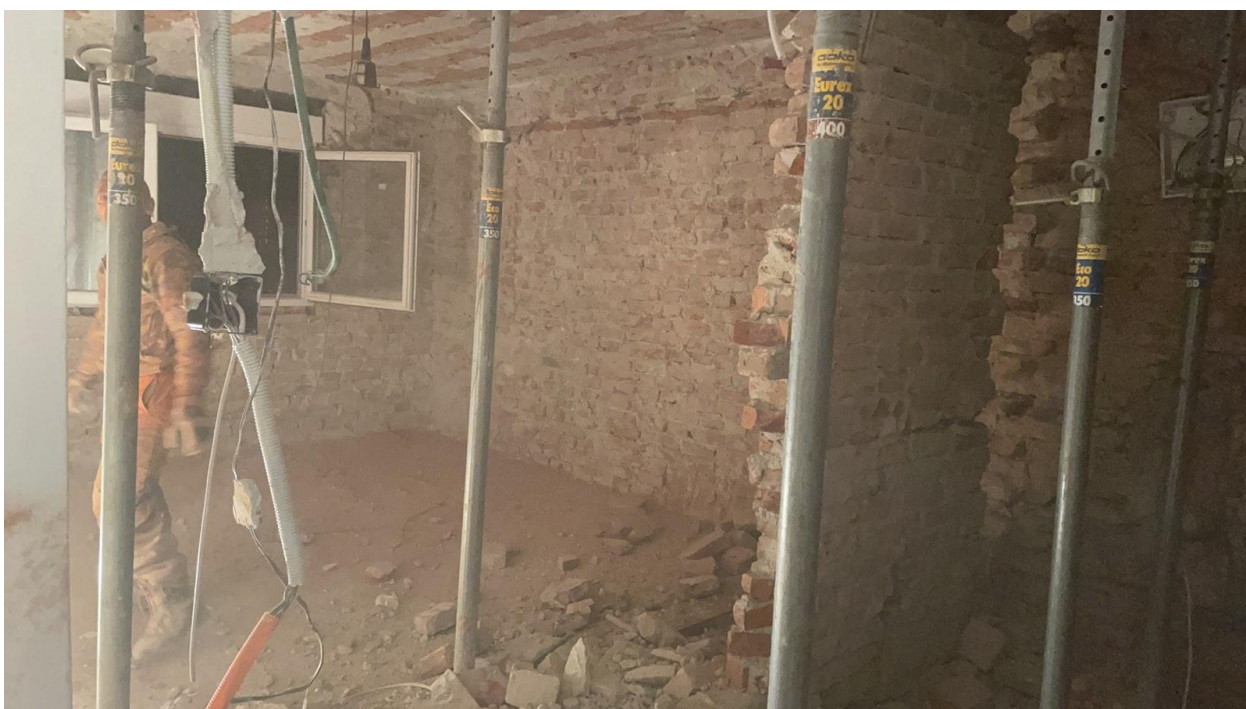
Slika 4.7 – Podupiranje postojeće konstrukcije
