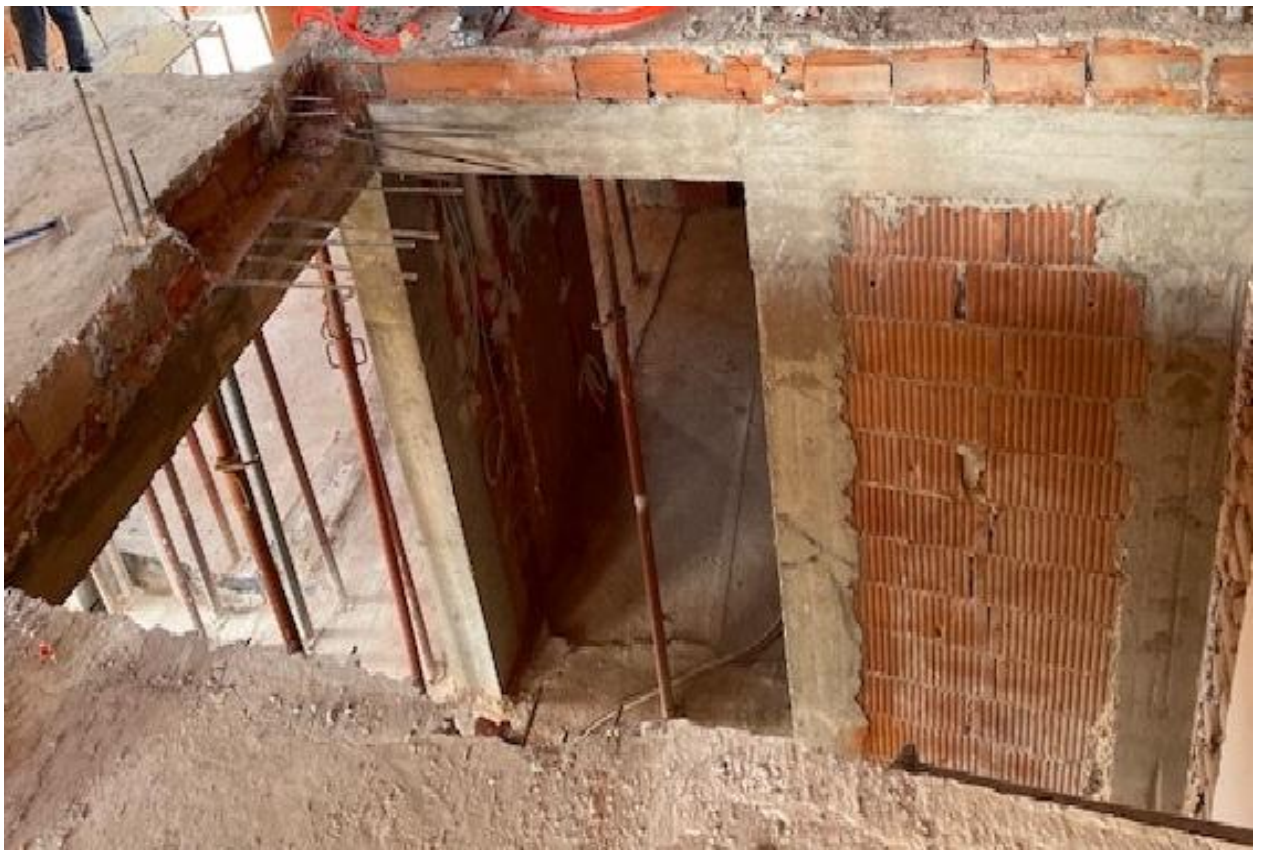
Slika 4.10 – Greda novog nosivog zida
