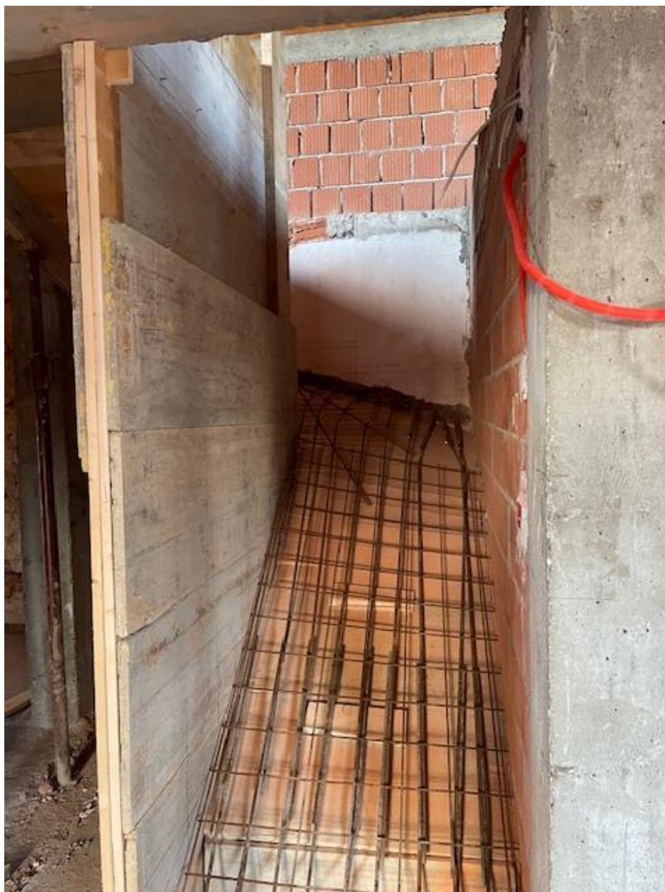
Slika 4.12 – Izrada novog stubišta
