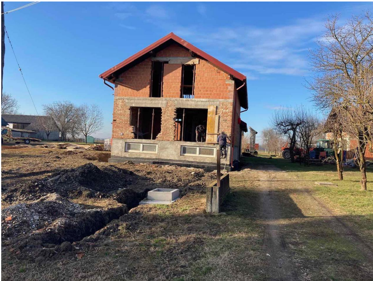
Slika 4.18 – Proširivanje otvora
