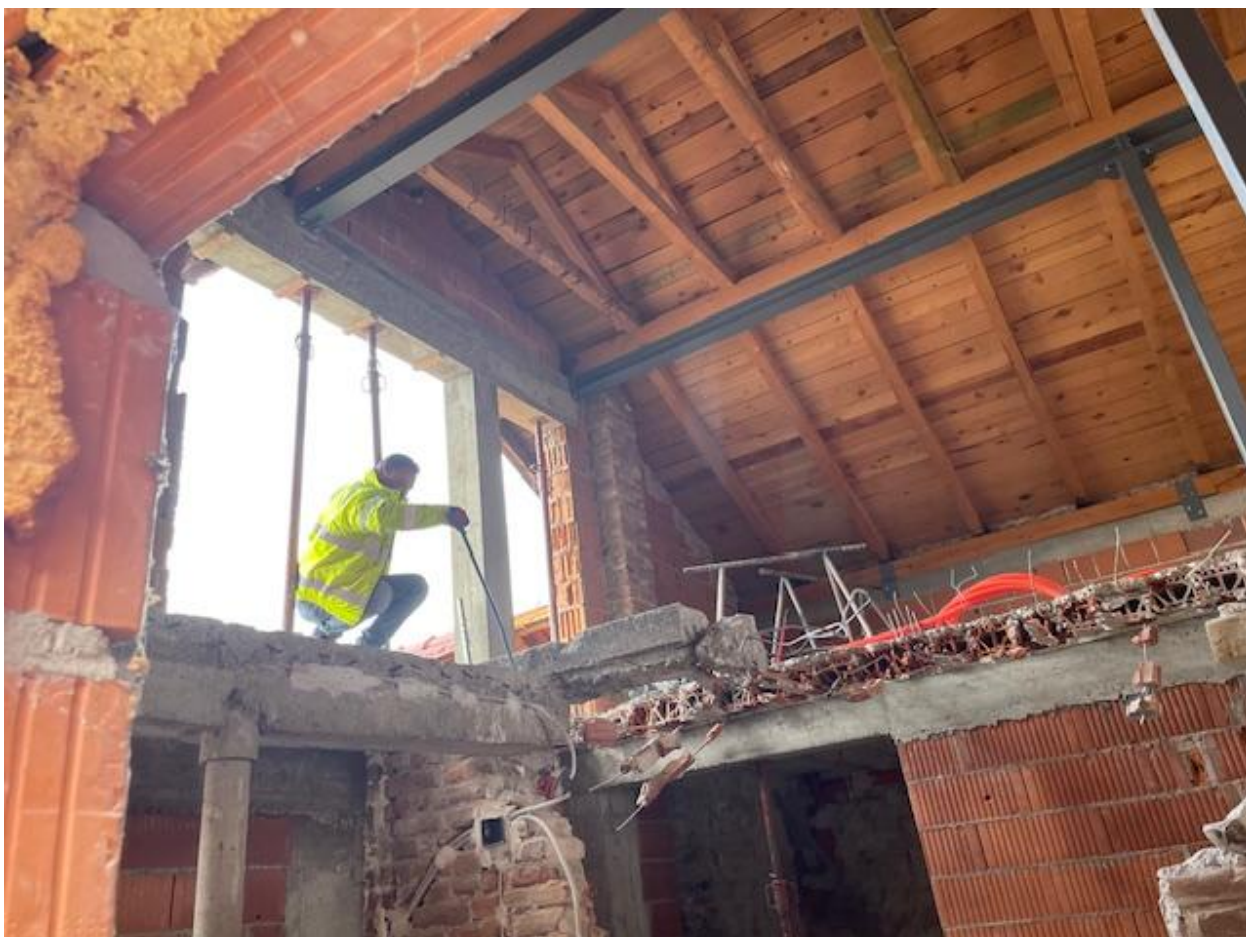
Slika 4.20 – Rušenje stropa
