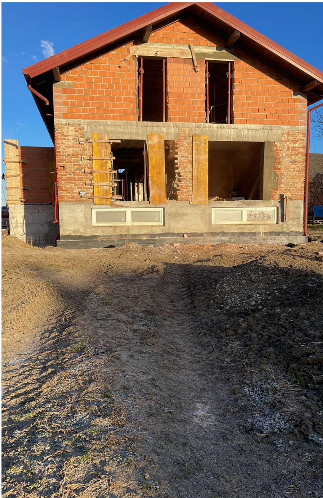
Slika 4.19 – Betoniranje vertikalnih i horizontalnih serklaža
