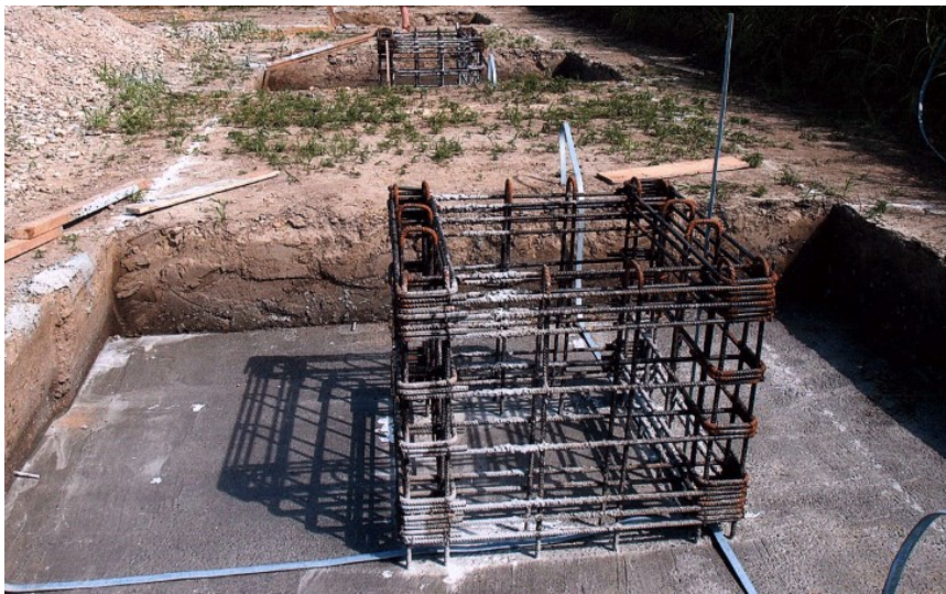
Slika 6 Betoniranje temeljnih stopa
