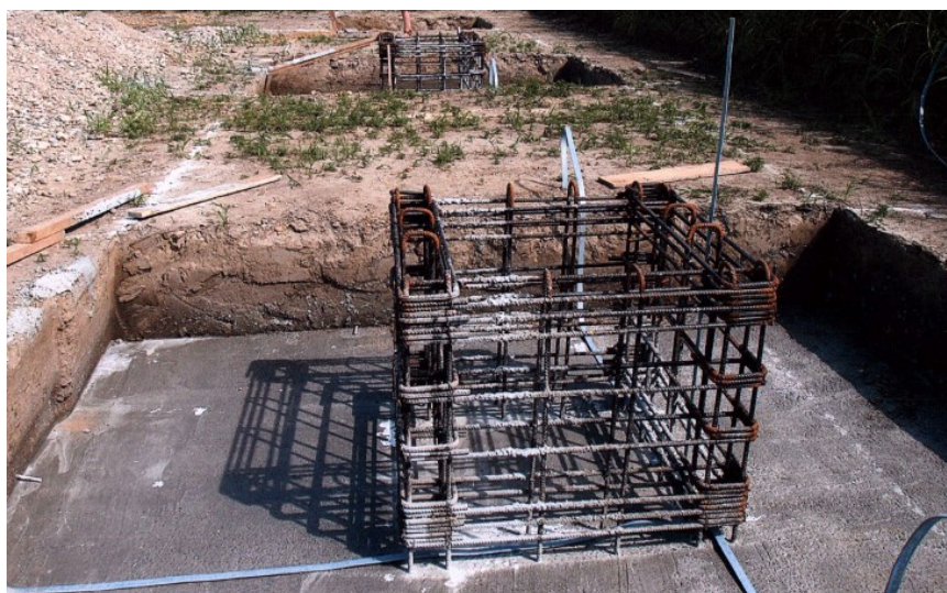
Slika 6 Betoniranje temeljnih stopa
