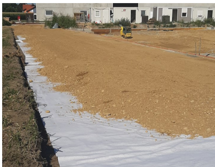
Slika 4 Postavljanje geotekstila i izvedba tampona šljunkom
