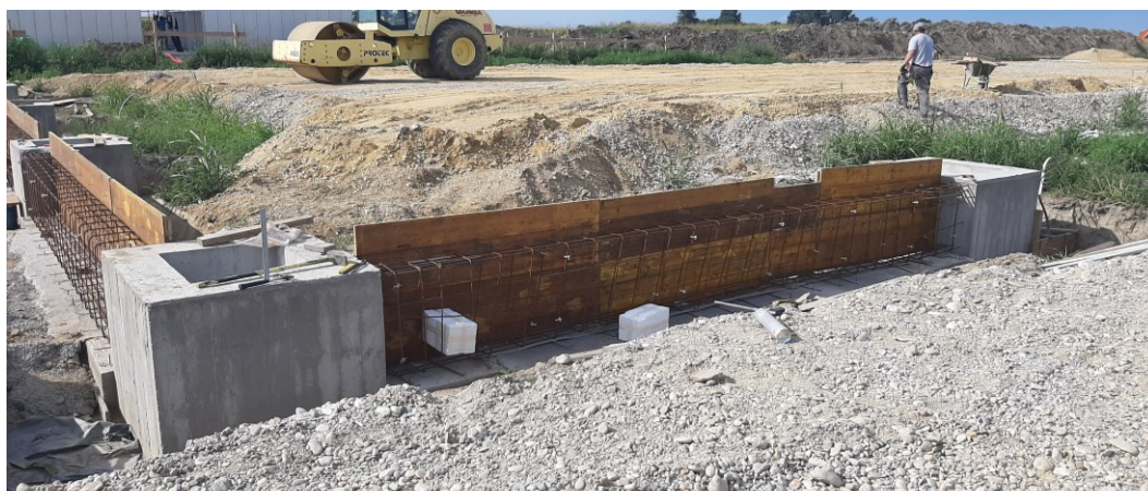
Slika 7 Priprema za betoniranje
