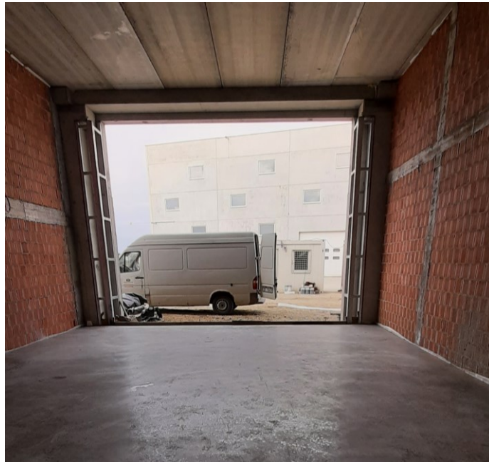
Slika 18 Zidovi u prizemlju
