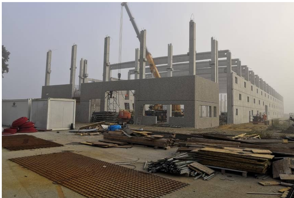
Slika 2 Prikaz građevine u procesu izgradnje
