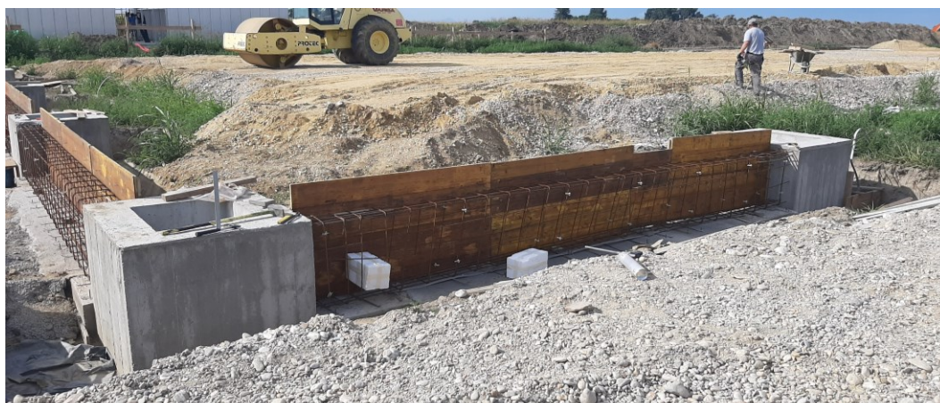
Slika 7 Priprema za betoniranje
