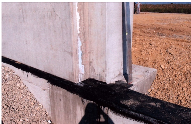
Slika 20 Hidroizolacija zidova
