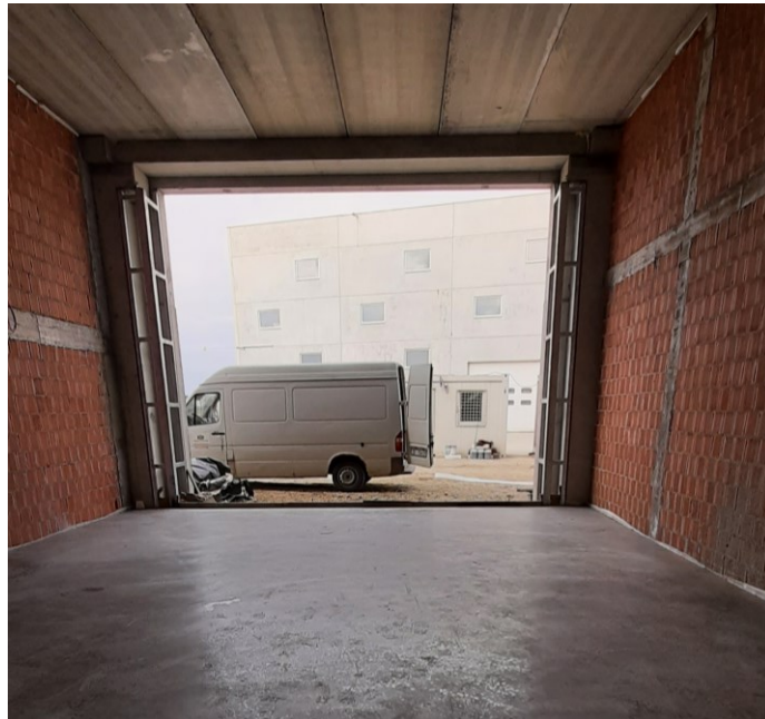
Slika 18 Zidovi u prizemlju
