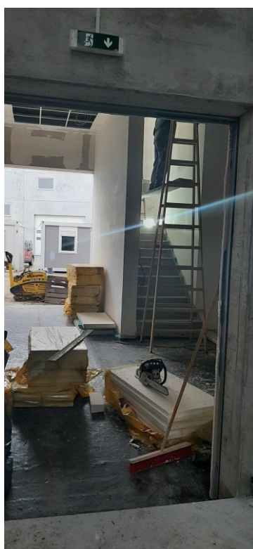
Slika 22 Toplinska izolacija podova
