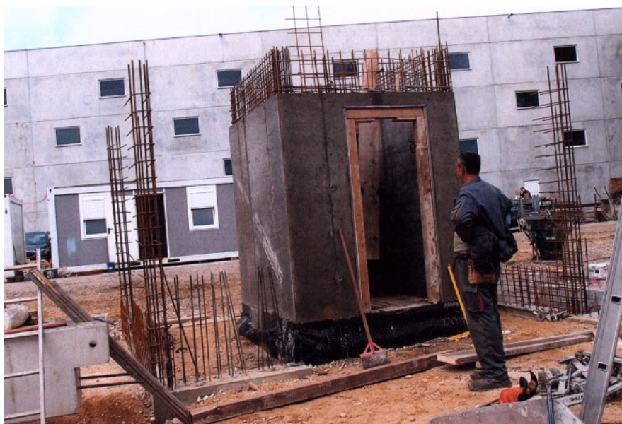
Slika 21 Hidroizolacija dizala
