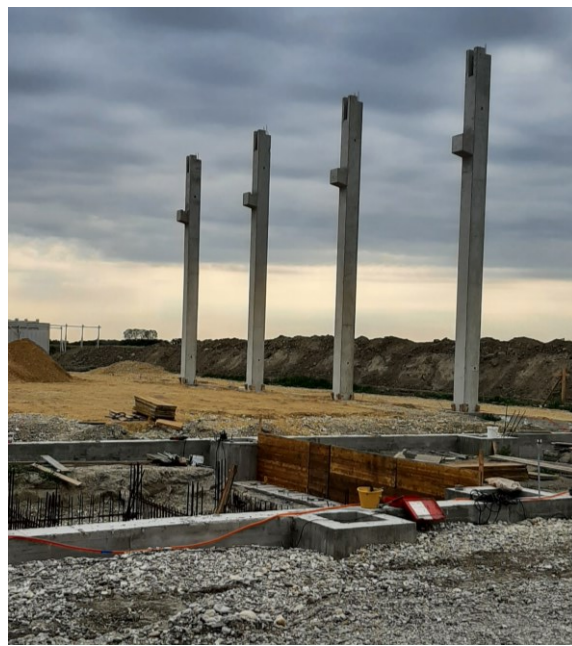
Slika 12 Postavljeni stupovi
