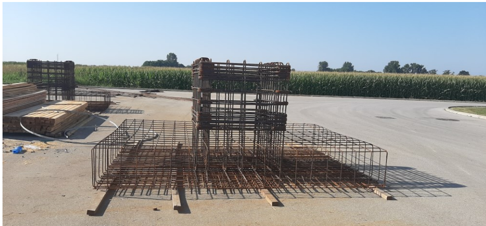
Slika 5 Armatura temeljne stope i čašice
