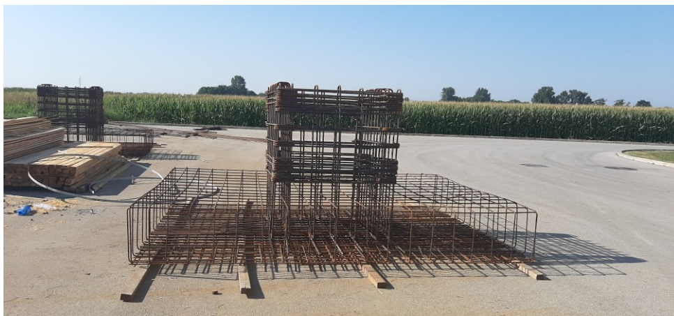
Slika 5 Armatura temeljne stope i čašice
