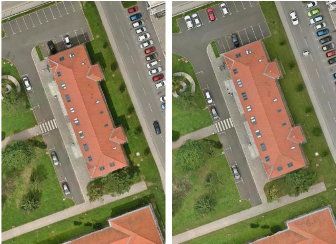
Slika 13. DOF zgrade UNIN3 Sveučilišta Sjever iz vertikalnih snimki (desno) i kosih snimki (lijevo)
