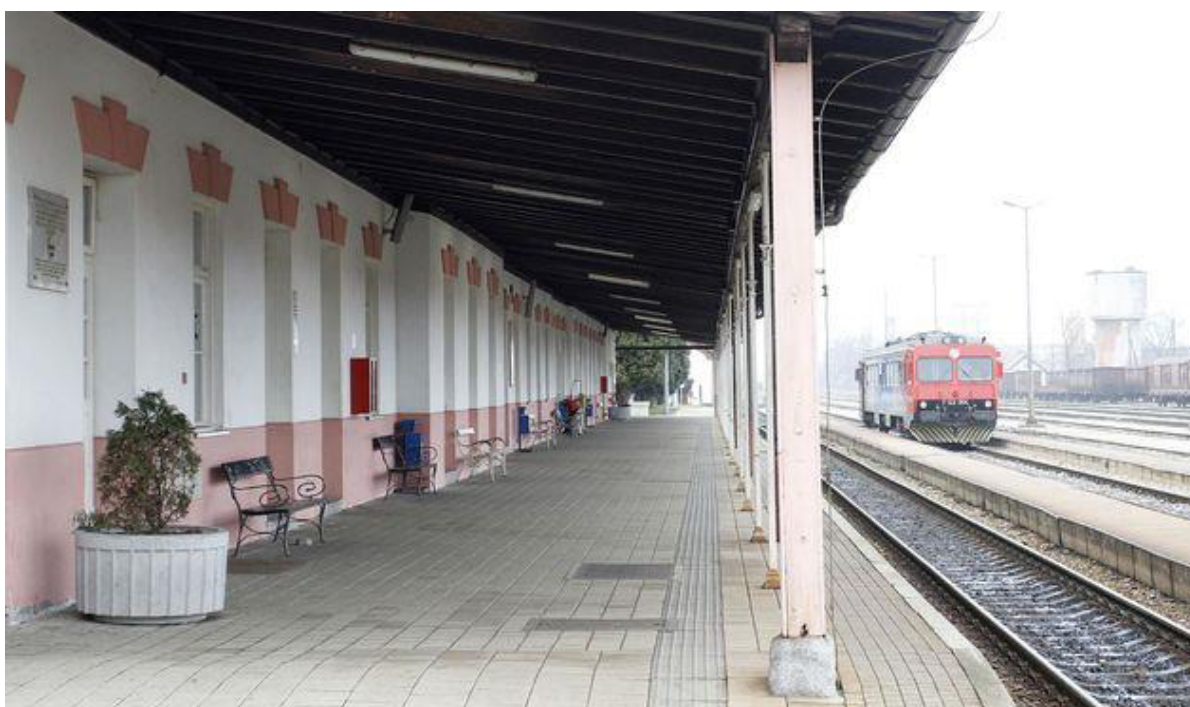
Slika 24 - Željeznički kolodvor Čakovec
