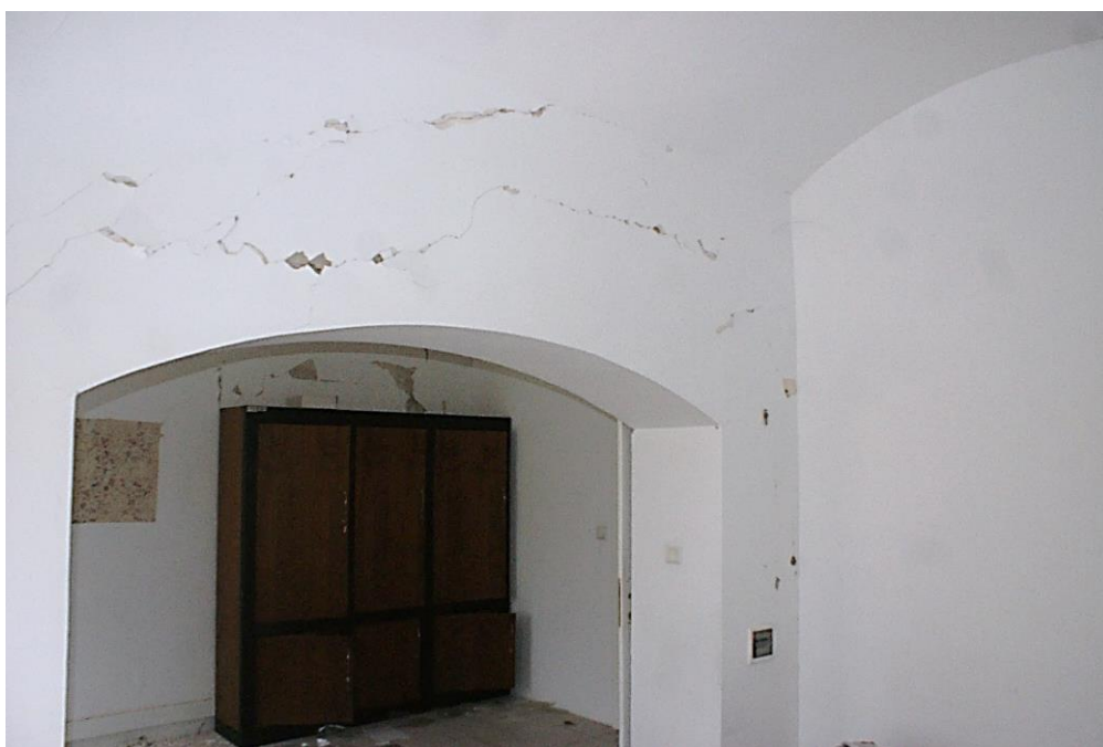
Slika 5.3 Prostorija 7. Horizontalna pukotina na zidu
