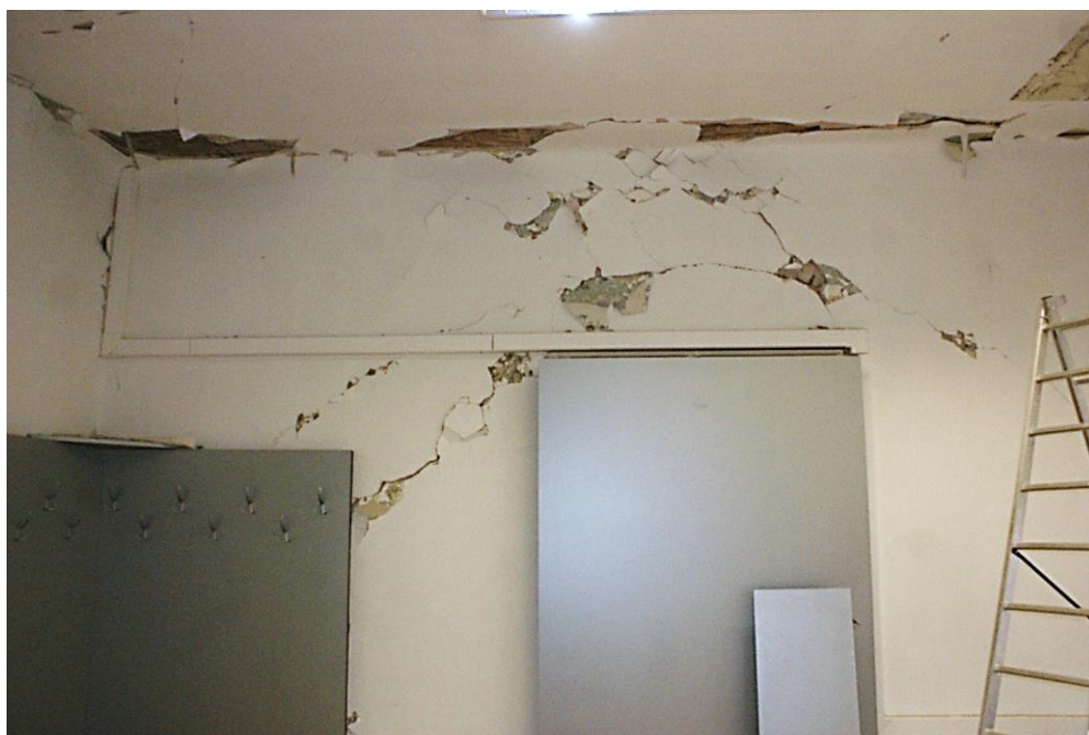
Slika 5.11 Prostorija 3. Oštećenje nadvoja
