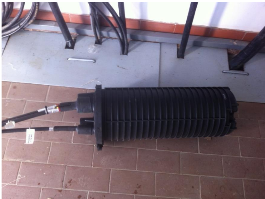
Slika 3.8. Optička spojnica (izvor: autor)
