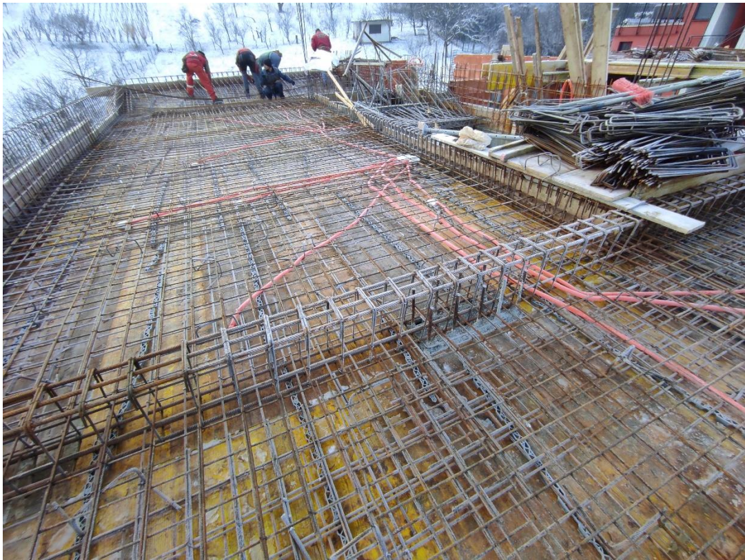
Slika 3.4.2. Postavljanje armature za stropnu ploču
