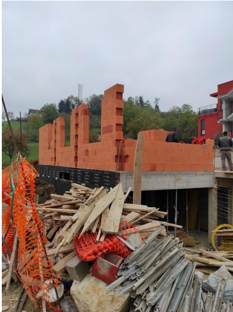
Slika 3.6.1. Zidanje opekom tipa Wienerberger Profi 25
