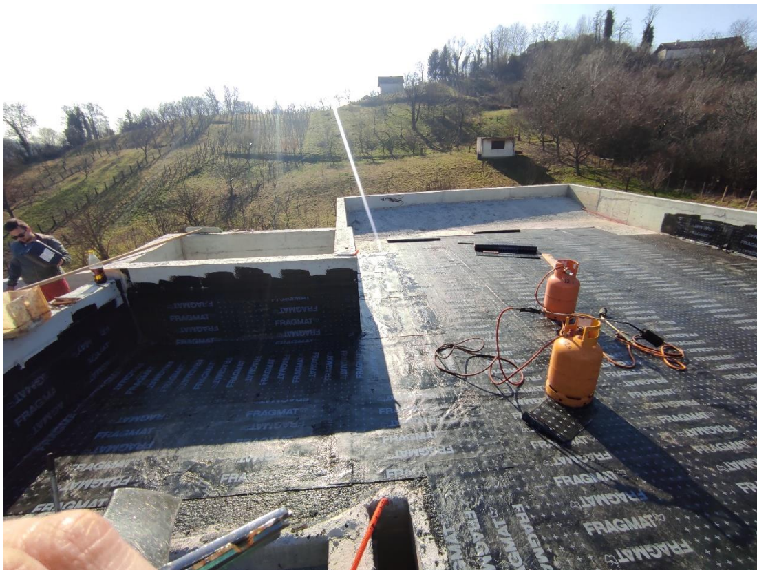
Slika 3.7.1.2. Postavljanje hidroizolacije
