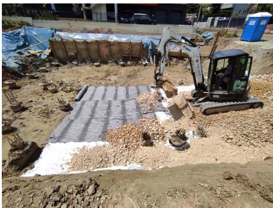
Slika 3.2.5.1. Ugradnja kamenog agregata
