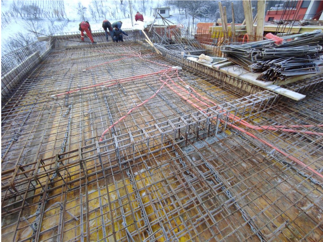
Slika 3.4.2. Postavljanje armature za stropnu ploču
