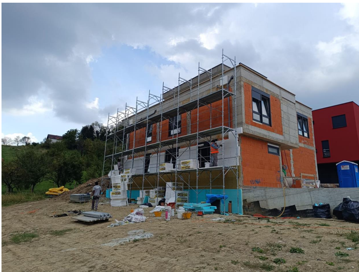
Slika 3.8.1. Postava EPS ploča na vanjske zidove
