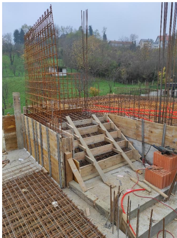
Slika 3.5.6.1. Betoniranje stepenica
