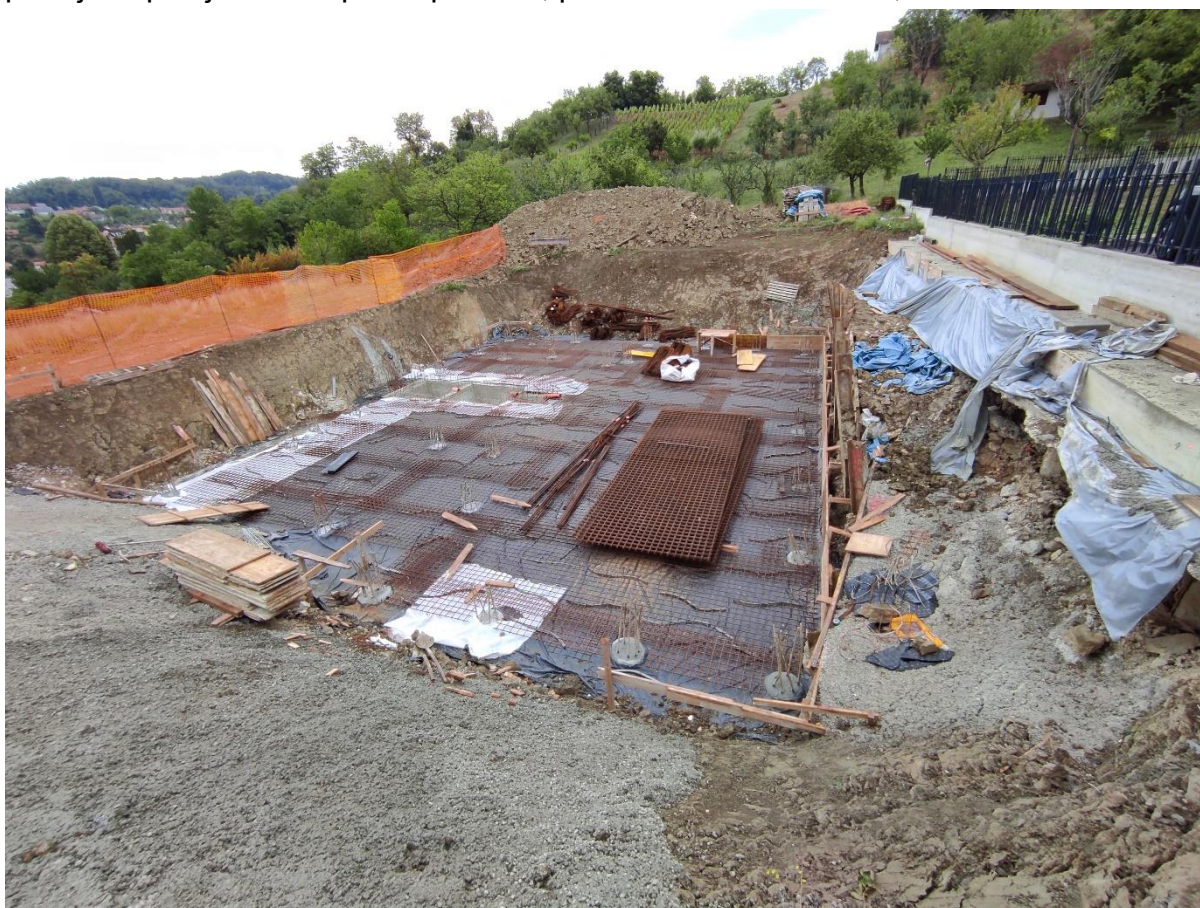
Slika 3.4.1. Postavljanje armature za temeljnu ploču
