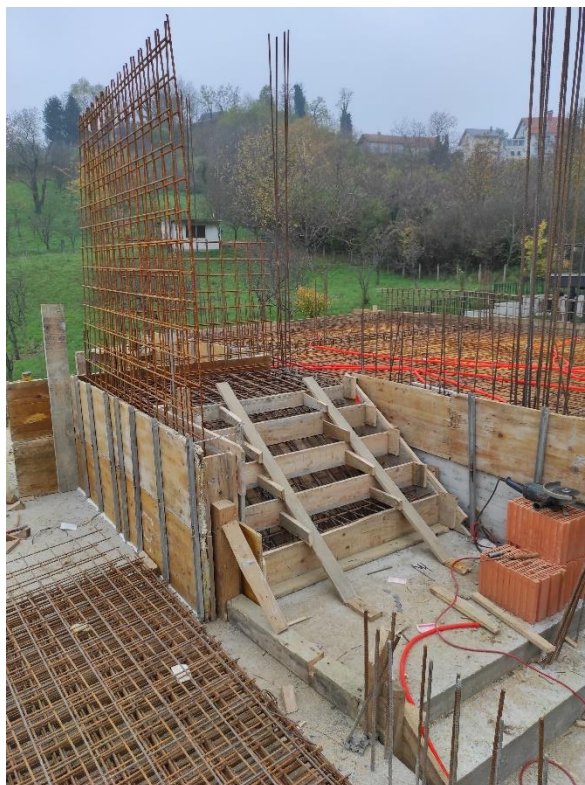
Slika 3.5.6.1. Betoniranje stepenica
