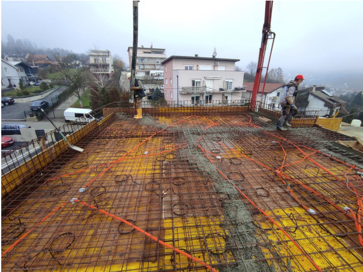
Slika 3.5.4.1. Betoniranje stropne AB ploče
