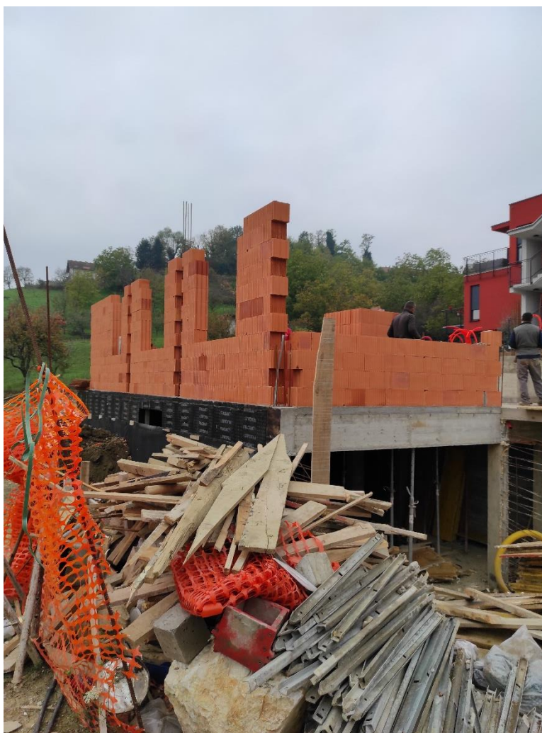
Slika 3.6.1. Zidanje opekom tipa Wienerberger Profi 25
