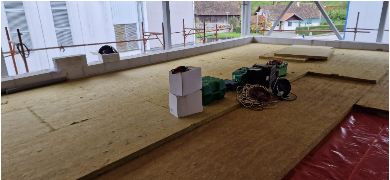
slika 3.6.1. postava izolacije na ravni krov objekta
