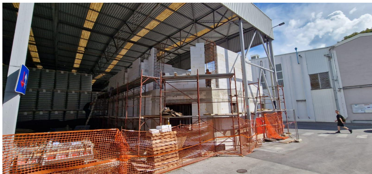
slika 3.5.3. postava skele za zidanje i zidanje vanjskih zidova
