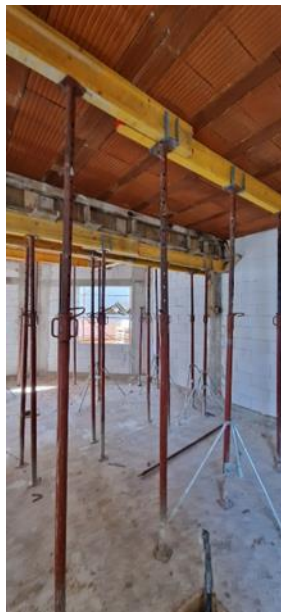
slika 3.3.3. postava oplata fert sustavom
