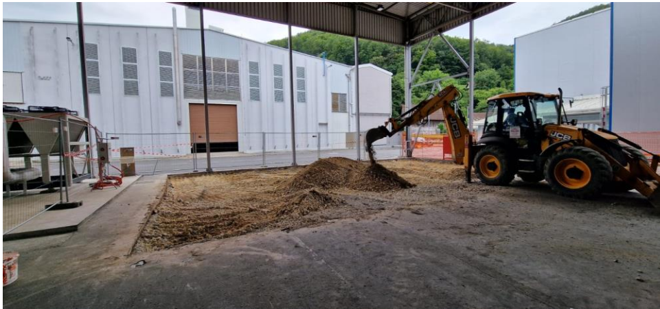
slika 3.2.1. prikaz početka iskopa za temelje
