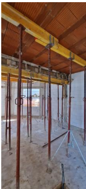
slika 3.3.3. postava oplata fert sustavom
