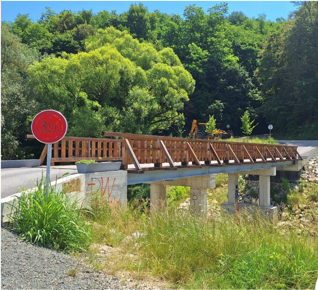
Slika 4.11. Novi (izgrađeni) most Lovrentovec [5]
