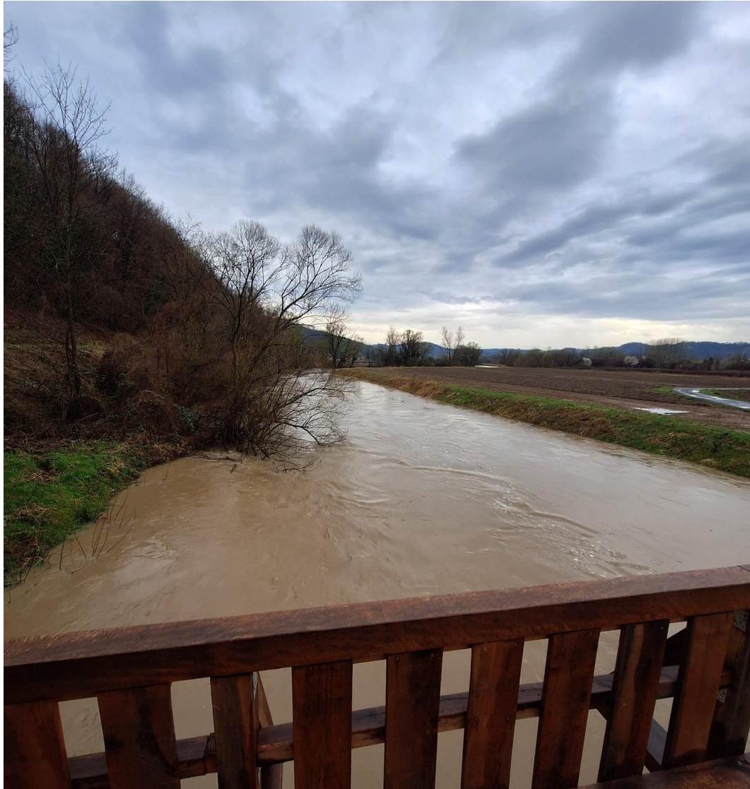
Slika 4.15. Pogled na uzvodnu stranu Bednje [5]
