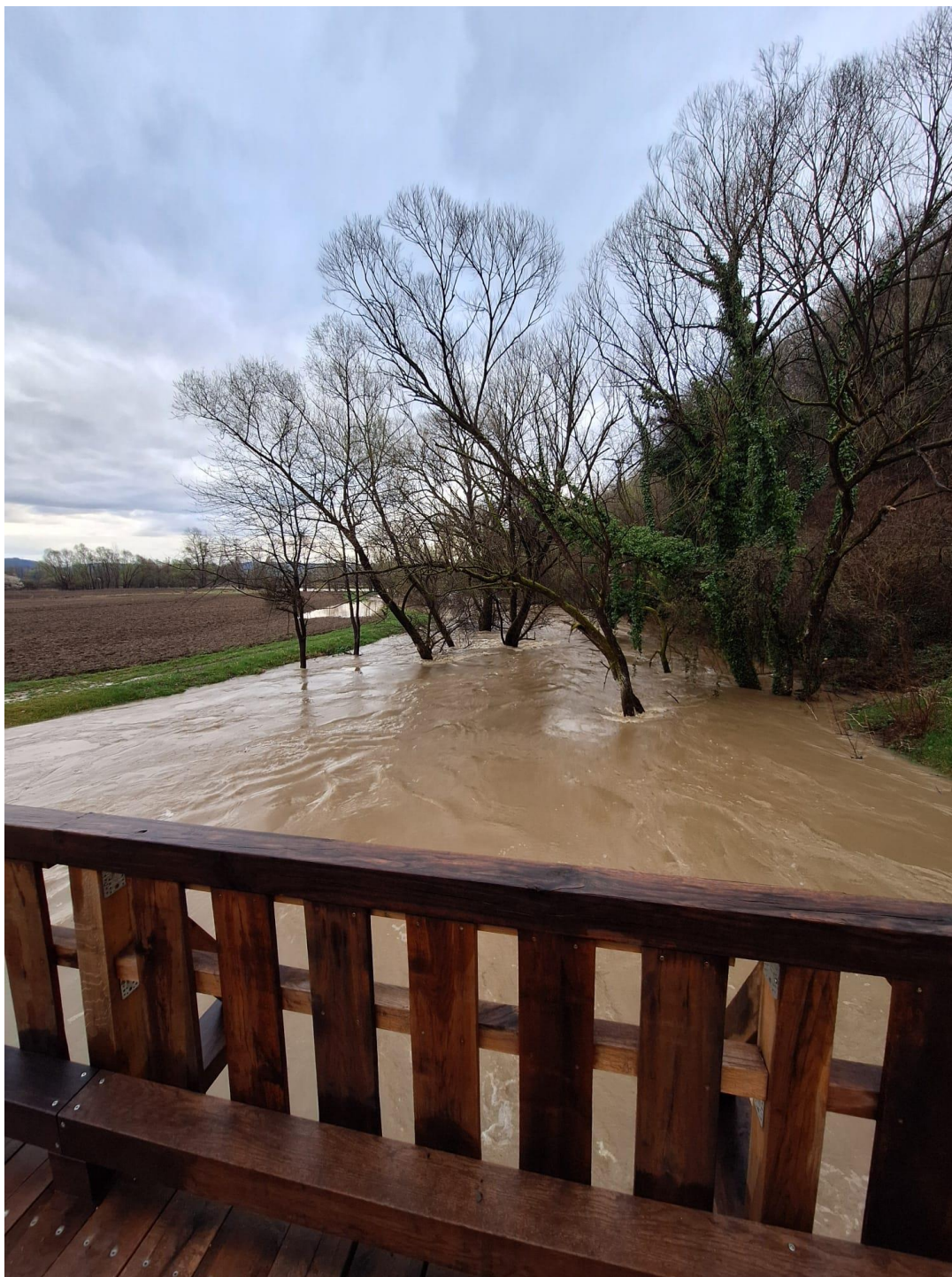
Slika 4.13. Pogled na nizvodnu stranu Bednje [5]
