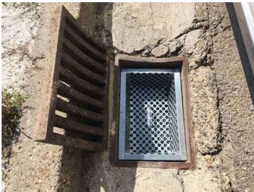
Slika 10. Sugarfilter - Filter za oborinske odvode
