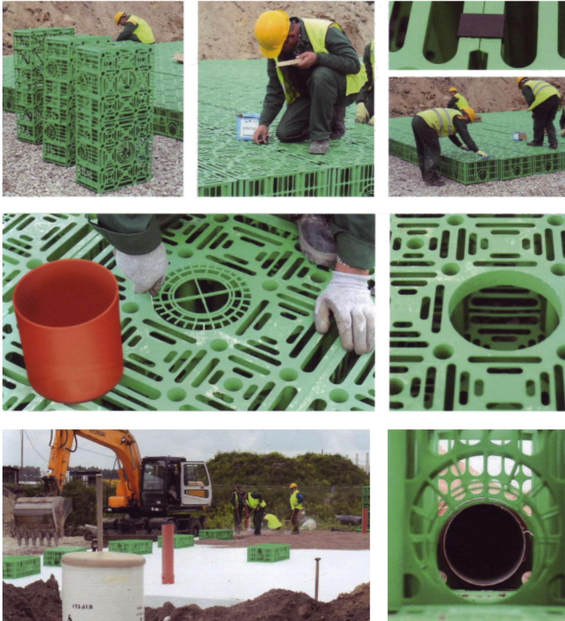
Slika 23. Proces montaže sustava Stormbox-a
