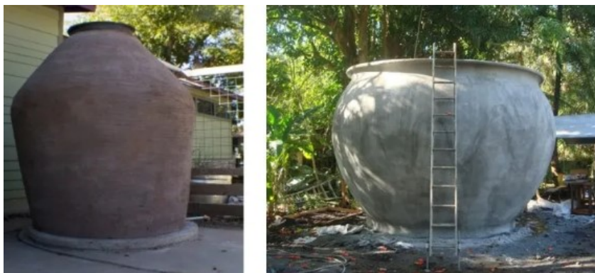
Slika 8. Spremnici od ferocementa
