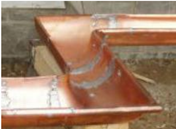
Slika 7.2. Lemljenje bakrene okapnice [6]
