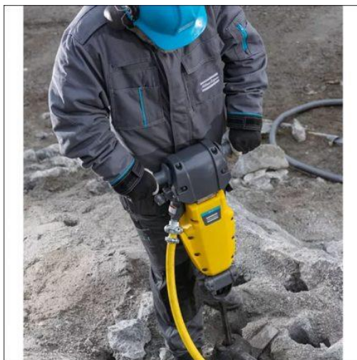
Slika 15. Prikaz korištenja pneumatskog čekića u praksi [25]
