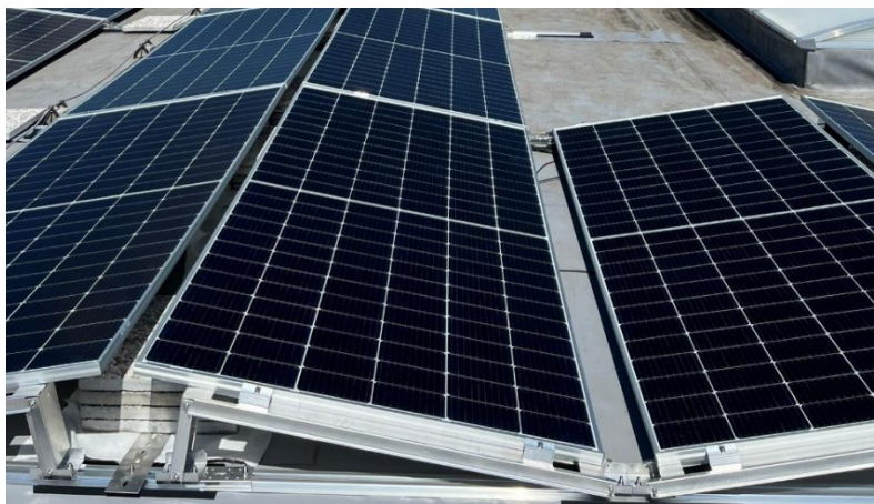
Slika 3.7. Konstrukcijski elementi za limeni krov
