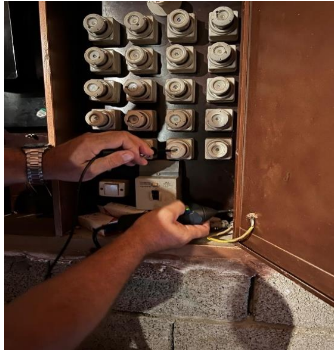
Slika 5.1. Ispitivanje kontinuiteta zaštitnog vodiča i vodiča za izjednačavanje potencijala
