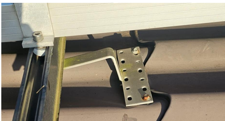
Slika 4.1. Potkonstrukcija za crijep montirana na limu
