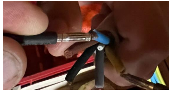
Slika 5.4. Ispitivanje električnog izolacijskog otpora vodiča
