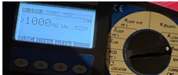
Slika 5.5. Rezultati dobiveni ispitivanjem električnog izolacijskog otpora vodiča
