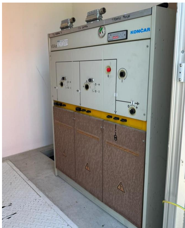
Slika 12. SN sklopni blok VDAΣ 24-2VT
