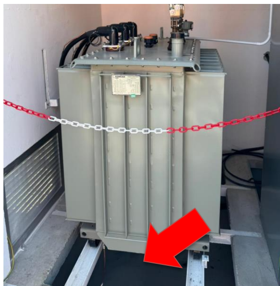
Slika 9. Podni otvor za prihvat iscurjelog ulja
