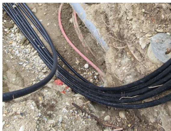
Slika 20. Kabel NA2XS(F)2Y (1x185RM/25mm 2 ) položen u kabljski rov
