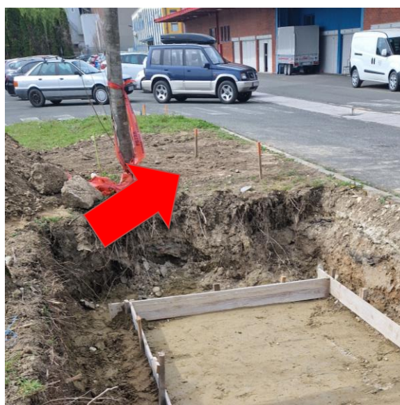
Slika 5. Iskolčenje kablenske trase
