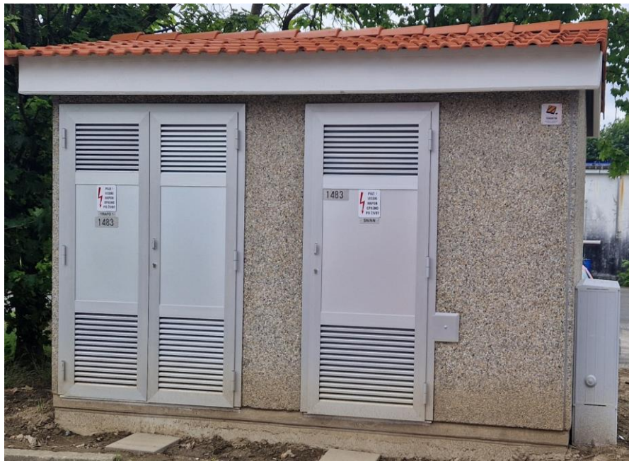
Slika 10. Vanjski izgled TS-a – naprijed
