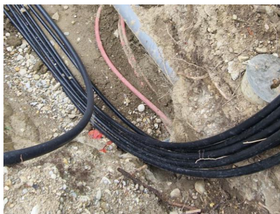
Slika 20. Kabel NA2XS(F)2Y (1x185RM/25mm 2 ) položen u kabljski rov
