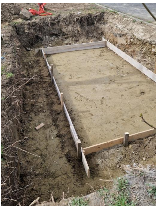
Slika 6. Priprema i iskop temelja
