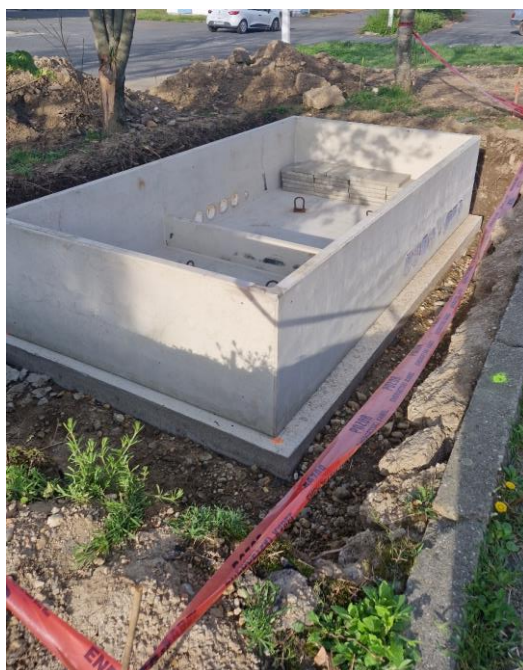
Slika 25. Ograđivanje armiranobetonskog temelja PVC trakom upozorenja
