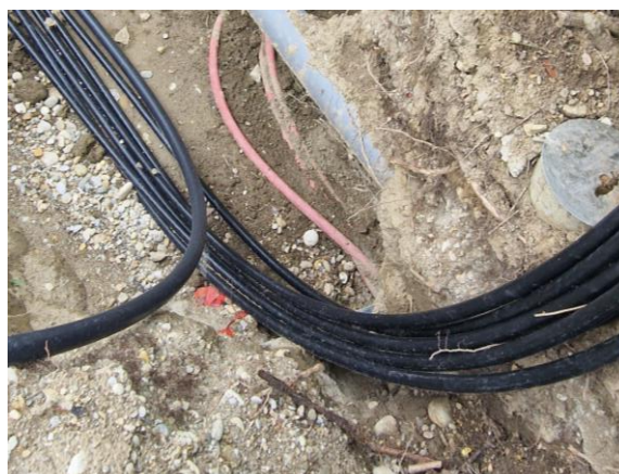
Slika 20. Kabel NA2XS(F)2Y (1x185RM/25mm 2 ) položen u kabelski rov
