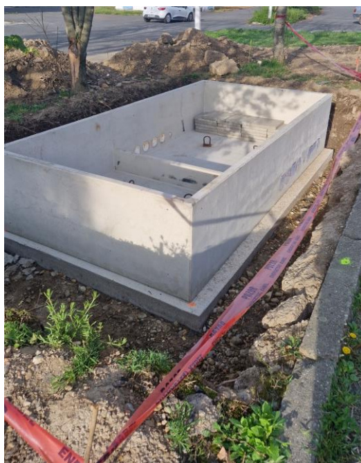
Slika 25. Ograđivanje armiranobetonskog temelja PVC trakom upozorenja
