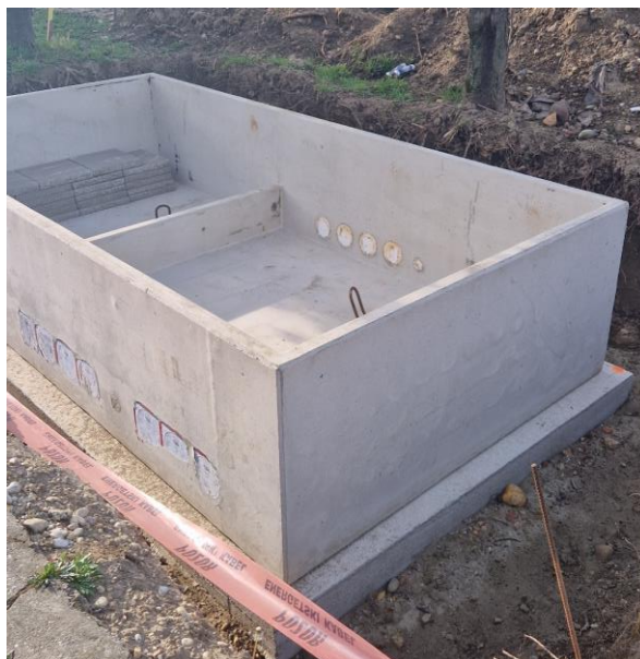
Slika 7. Armiranobetonski temelj u obliku kompaktne kade
