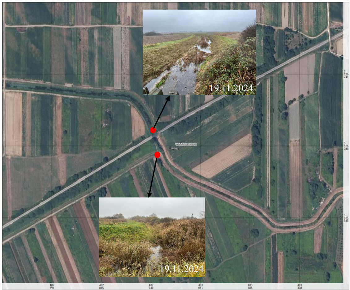
Slika 42 Prikaz trenutnog stanja vodotoka rijeke Plitvice kod naselja Zamlača [25]
