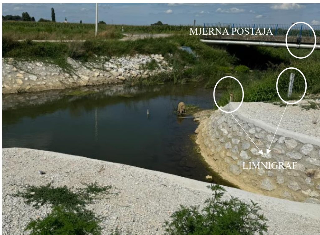
Slika 26 Prikaz profila korita sa mjernom postajom i limnigrafom [25]
