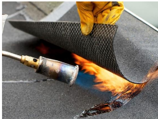
Slika 9.1.1. Varenje bitumenske trake
