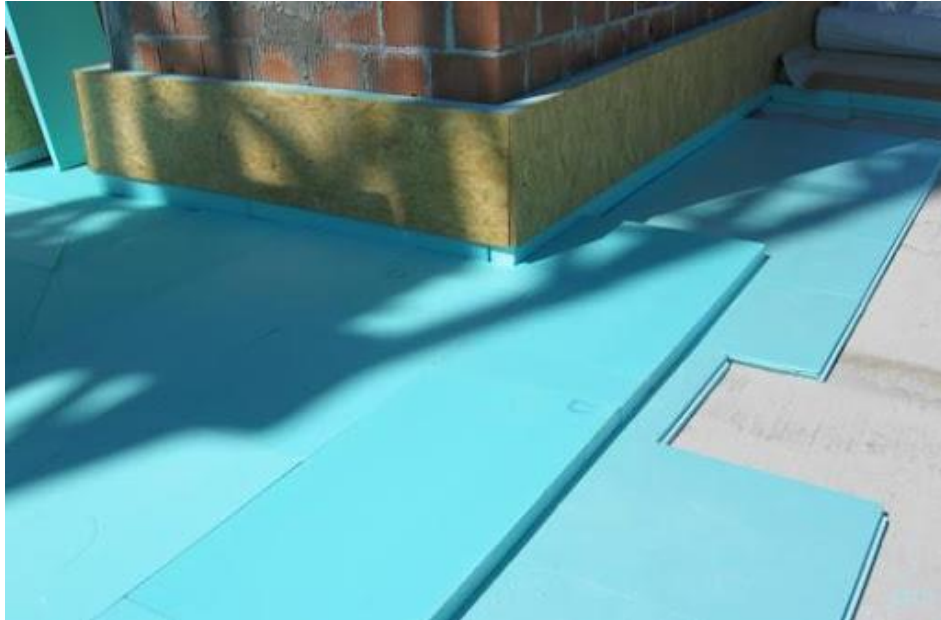
Slika 3.2.6. Toplinska izolacija ravnog krova XPS pločama
