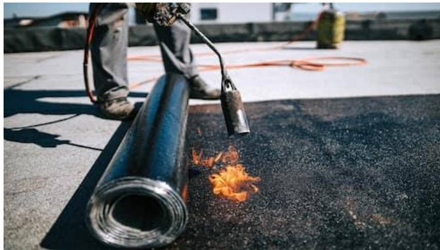
Slika 9.2.3. Polaganje ljepenke otvorenim plamenom
