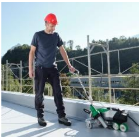
Slika 9.3.8. Varenje automatskim samohodnim strojem
