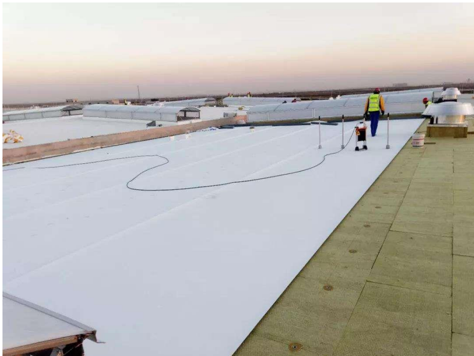
Slika 9.3.2. Polaganje TPO folija na ravni krov
