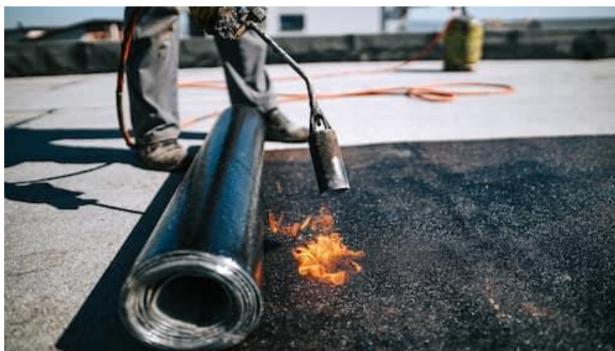
Slika 9.2.3. Polaganje ljepenke otvorenim plamenom
