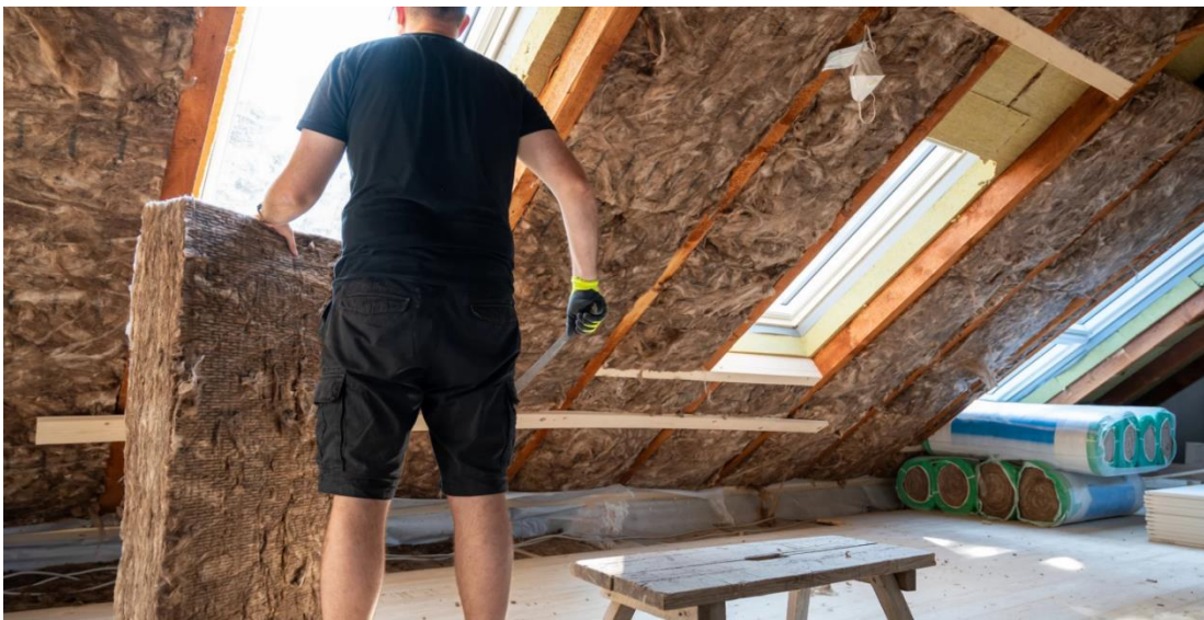
Slika 4.3.5. Izolacija potkrovlja staklenom mineralnom vunom
