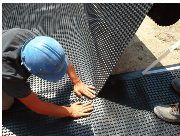
Slika 9.5.1. Postavljanje čepaste folije
