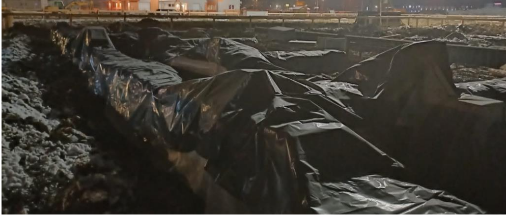
Slika 19. - Njega betona u zimskim uvjetima
