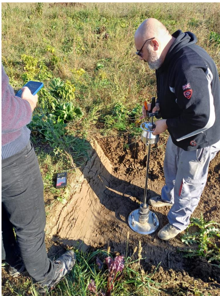
Slika 11. - Kontrola temeljnog tla sa dinamičkom kružnom pločom
